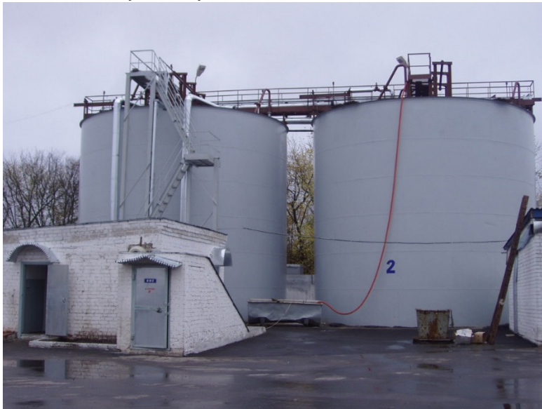
Рис. 1. Очисні споруди Шосткінського міськмолкомбінату
