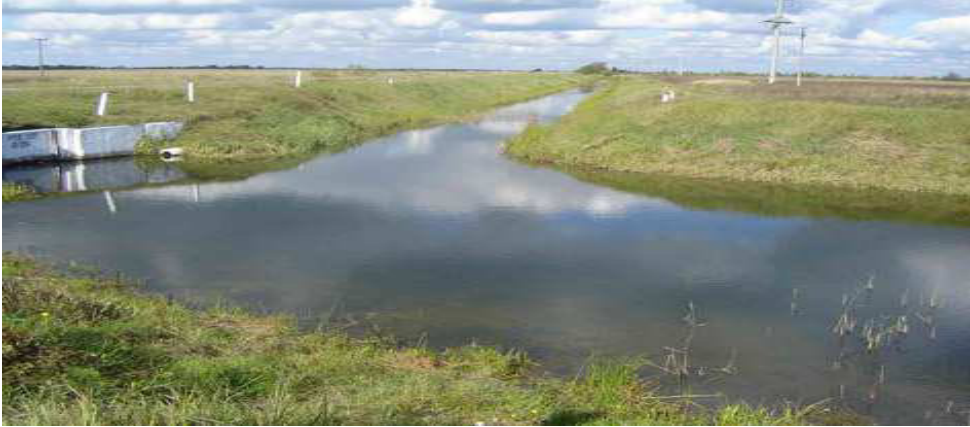
Рис. 1. Підтоплення водогосподарської системи ґрунтовими водами Результати досліджень
