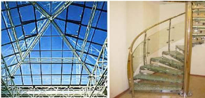
Рис. 1.24. Світлопрозорий скляний дах і скляні гвинтові сходи
