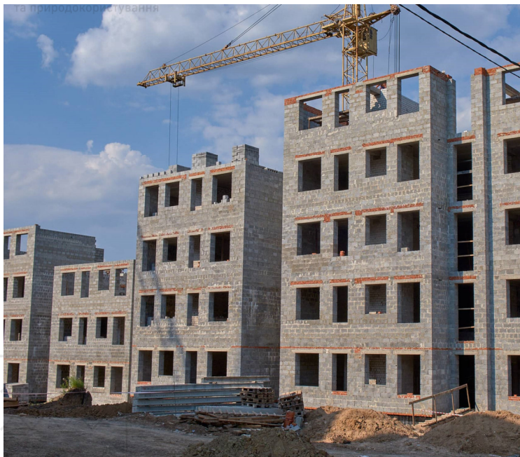
Рис. 1.19. Будівництво багатоповерхових будівель із застосуванням блоків з керамзитобетону
