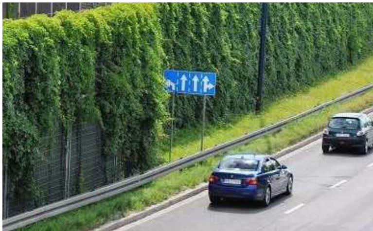
Рис. 7. Шумозахисний екран поглинаючого типу «зелена стіна»
