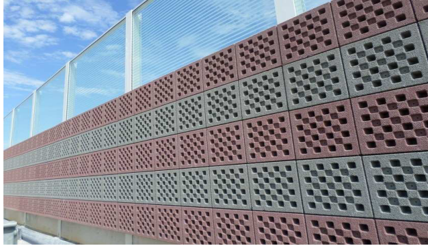
Рис. 4. Стіна з блоків та панелей армованого плексигласу зверху
