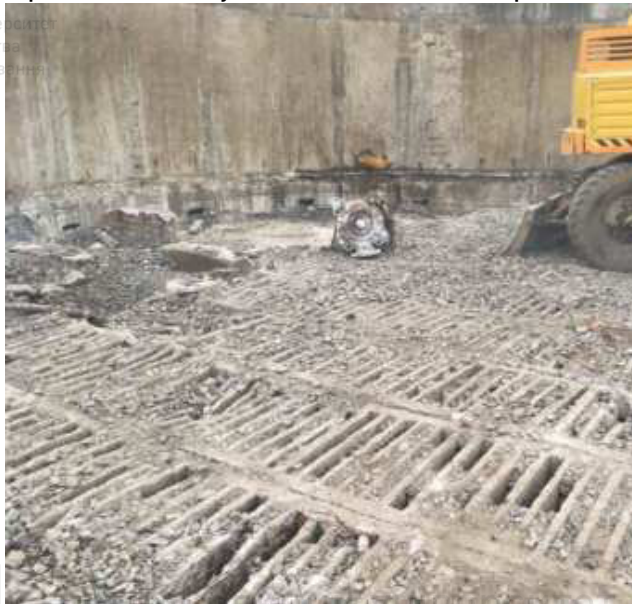
Рис. 2. Вивантаження і демонтаж дренажу біофільтра
