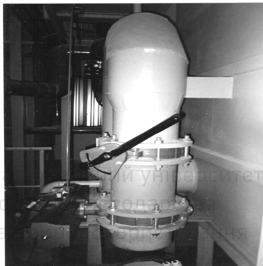
Рис. 1. Сифон малої висоти із електромагнітним клапаном для промивки пінополістирольного фільтра
