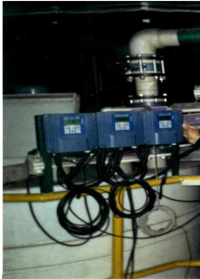
Рис. 3. Реактор-змішувач із системою контролю рН та Eh (виносні датчики та вторинні вимірювальні прилади, власне фото)
