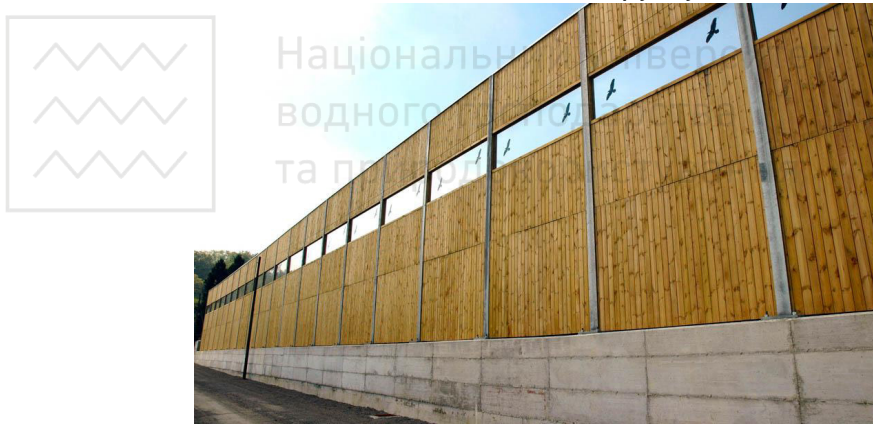
Рис. 8. Шумозахисні екрани з деревини на монолітному фундаменті
