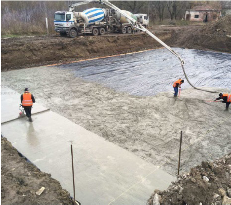
Рис. 4. Підготовка основи під комбіновані аеротенки
