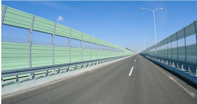
Рис. 5. Шумозахисний екран з пластику з комбінованими панелями – непрозорими і прозорими
