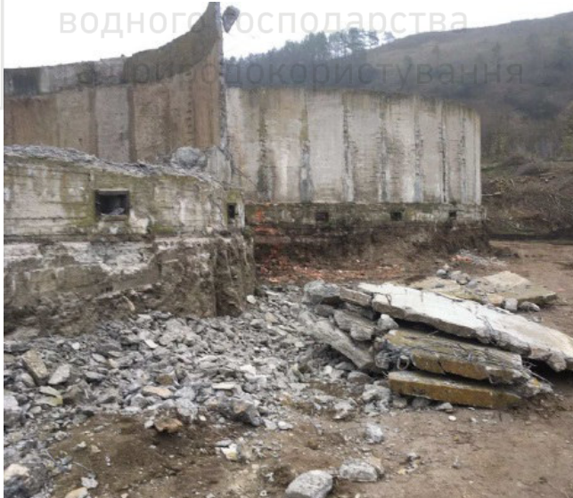
Рис. 3. Демонтаж стін біофільтра
