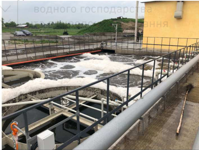
Рис. 6. Аеротенки очисних споруд міста Чортків
