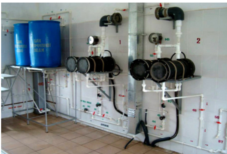
Станція електролізного хлорування питної води на базі напірних проточних установок ЕП-10-25 у м. Самборі Львівської області
