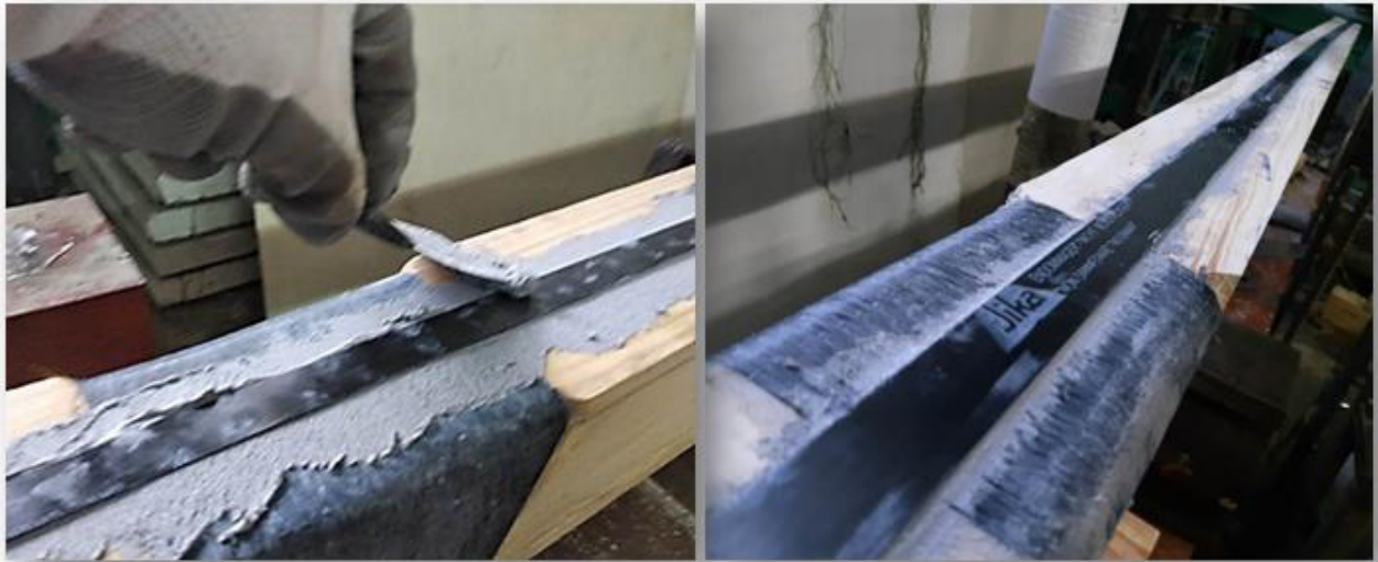
Рис. 2.8. Приклеювання стрічки Sika CarboDur S-512
