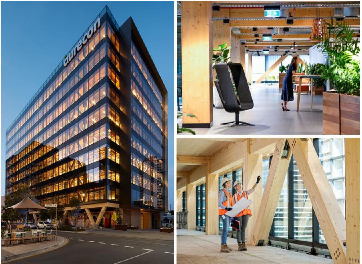
Рис. 1.14. Офісна будівля «25 King», м. Брісбен, Австралія
