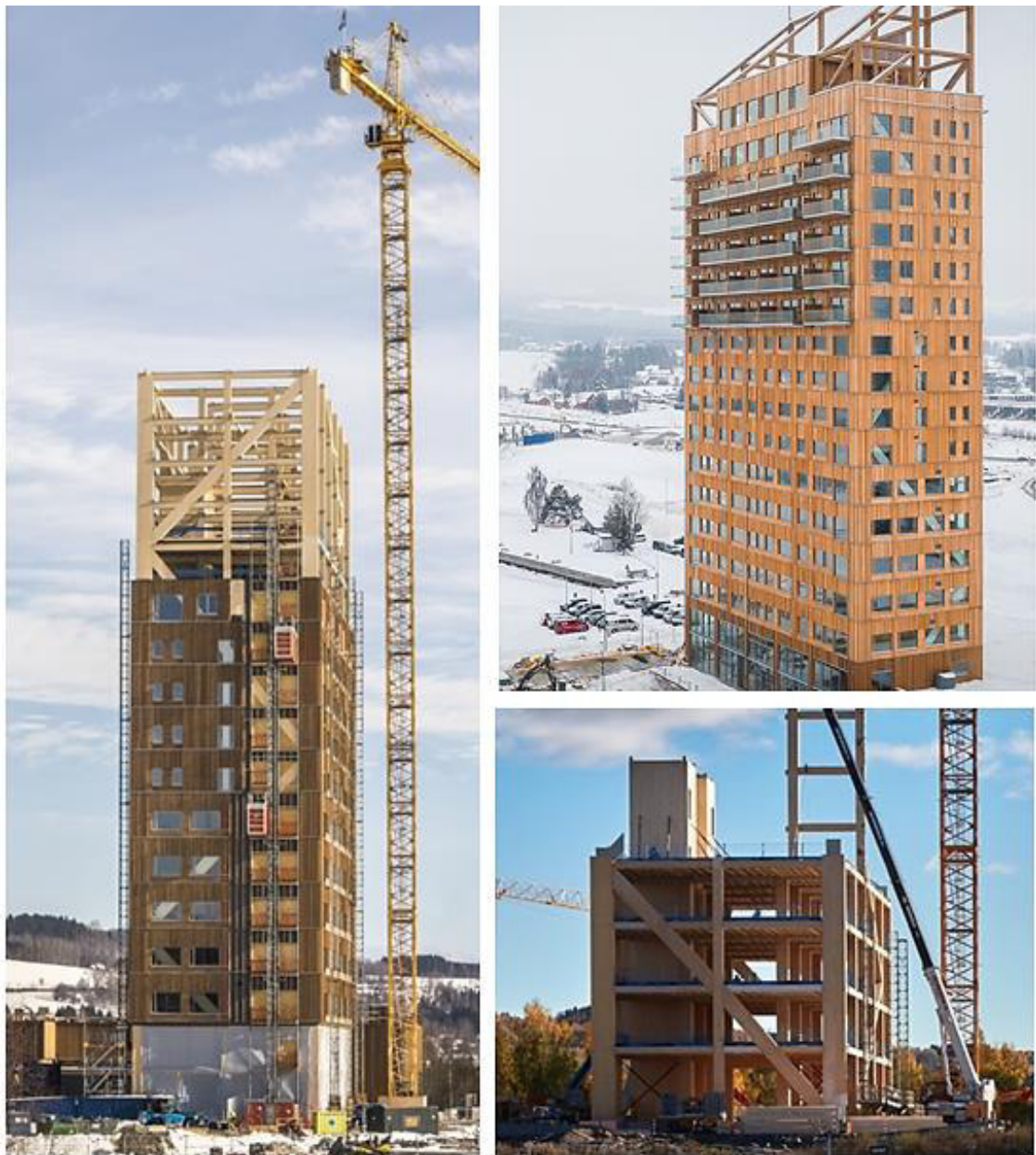
Рис. 1.12. Дерев'яна будівля «Мjøstårnet» висотою 85,4 м. м. Брумундаль, Норвегія
