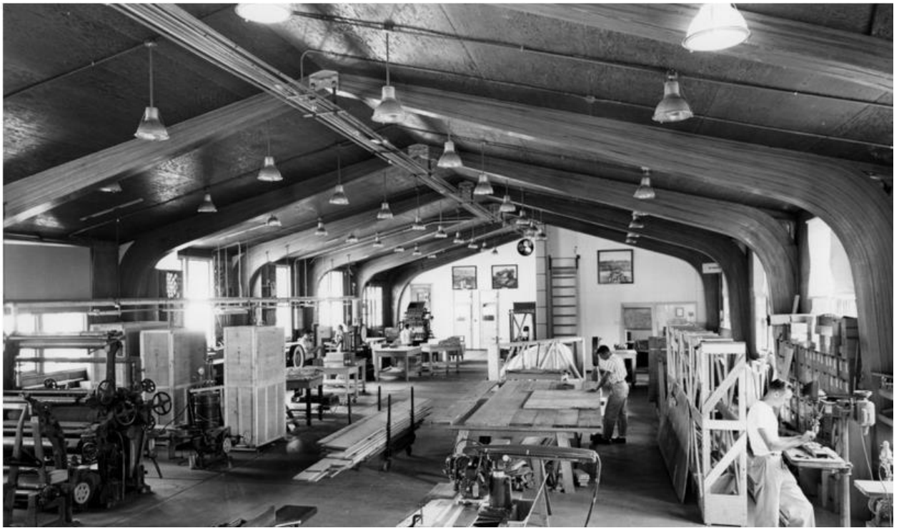
Рис. 1.2. Інтер'єр будівлі лабораторії лісових продуктів (FPL), побудованої із застосуванням клеєної деревини у 1934/1935 рр.
