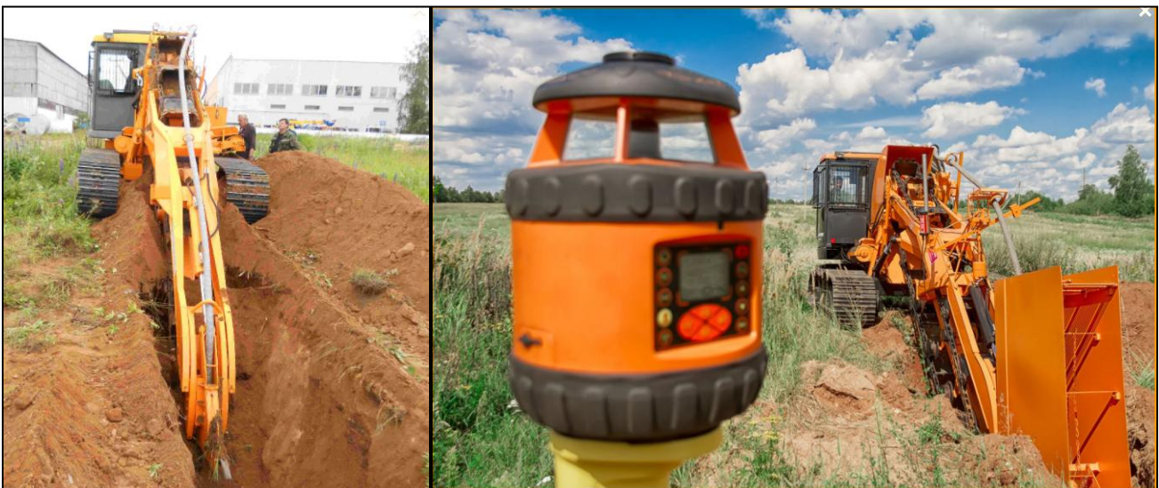
Рис.28. Робота траншейного екскаватора ЕТЦ-203.
