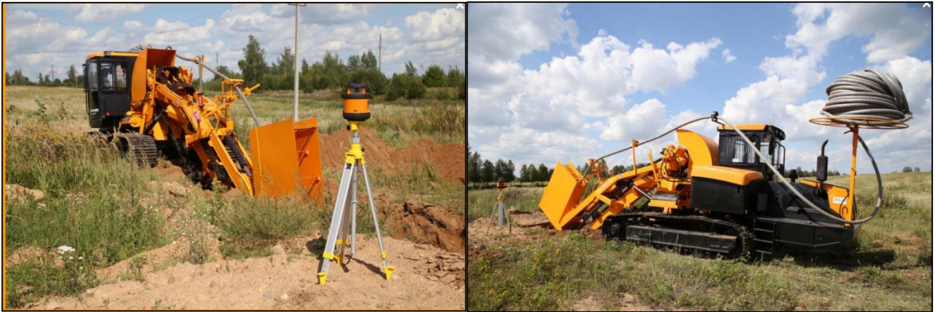
Рис.29. Работа траншейного экскаватора ЭТУ-354А.
