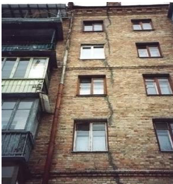
Рис. 1.2. Вигляд стіни будинку №19 по вул. Стадіонна в м. Києві ( http://n-auditor.com.ua/ru/component/na_archive/812?view=material )
