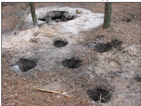
Рис. 6.7. Розвідувальні свердловини, пробурені перед проходкою шурфа
