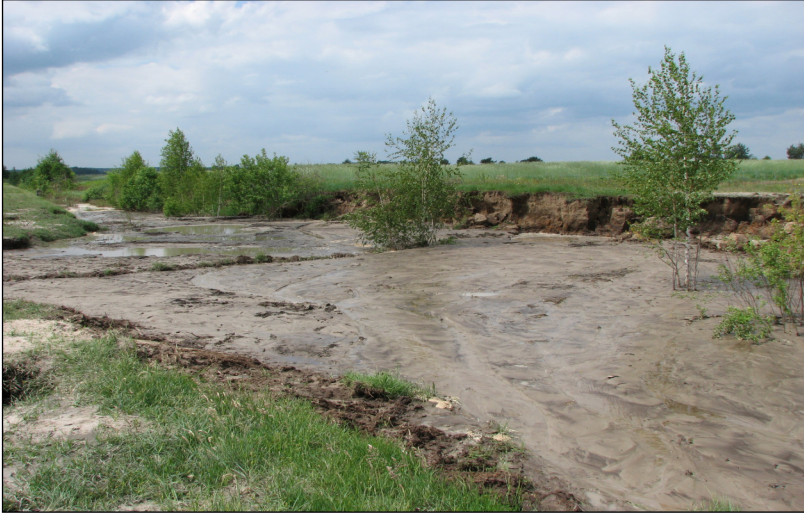
Рис. 6.14. Ділянка меліоративного каналу в районі с. Мочулище замита продуктами руйнування гірських порід внаслідок самовільного видобутку бурштину способом підземного гідровимивання
