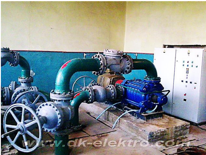
Рис. 3.2. Насосна установка обладана перетворювачами частоти потужністю 200 кВт
