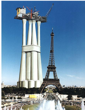
Рис. 1.7. Плавуча нафтова залізобетонна платформа у порівнянні з Ейфелевою вежею
