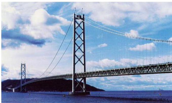
Рис. 1.8. Висячий міст Акасі - Кейко між островами Хонсю і Сікоку (Японія). Головний проліт 1991м
