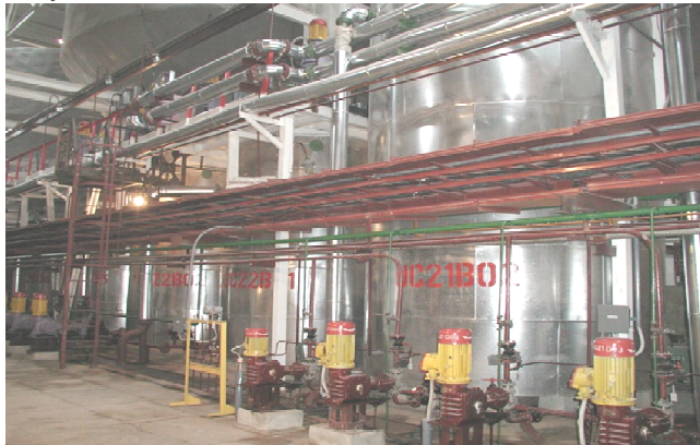
Рис. 5. Зовнішній вигляд баків-мірників коагулянту, флокулянту та бак-мішалок вапняного молока
