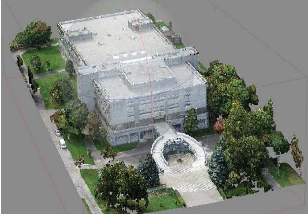
Рис. 2. Хмара точок фасадів будівлі одержана зі знімання БПЛА DJI Phantom 4 Pro
