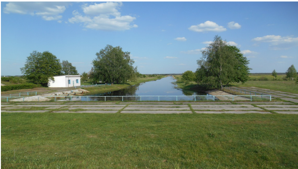
Рис. 1. Насосна станція осушувальної системи «Обірки» Сарненського району
