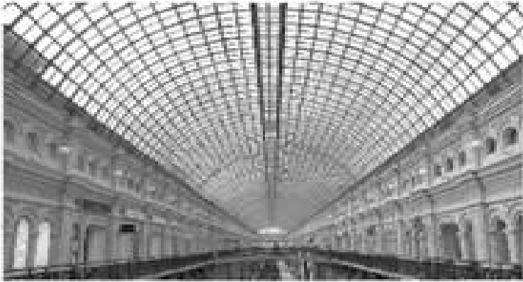
Рис. 1.3. Безарочне склепіння В.Г. Шухова
