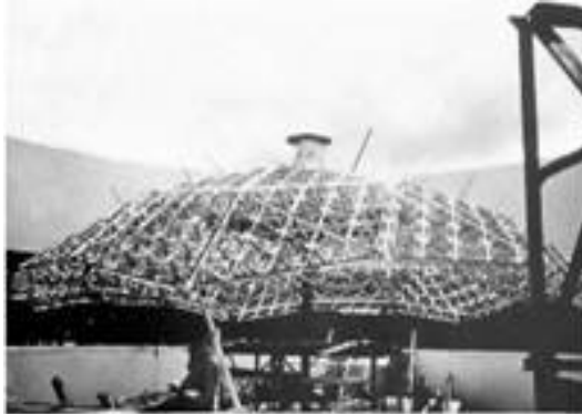
Рис. 1.1. Алюмінієвий купол системи "Октет Трас" Р.Б. Фуллера
