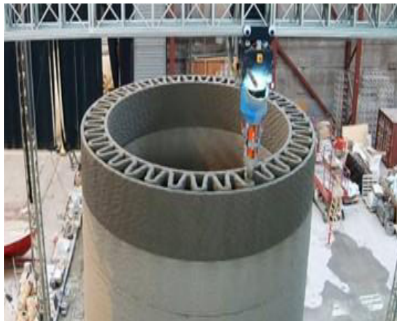
Рис. 3. 3D-друковані стіни для баз вітряних турбін
