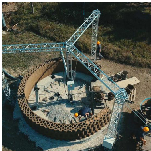
Рис. 1. Будинок Gaia надрукований на 3D-принтері з використанням природних матеріалів (грунт, відходи виробництва рису)
