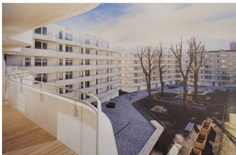
Рис.4 Житлова забудова Зільблок, міста Інсбрук, архітектори - Schenker Salvi Weber. Фотоколаж з книги «Усім потрібне житло».
