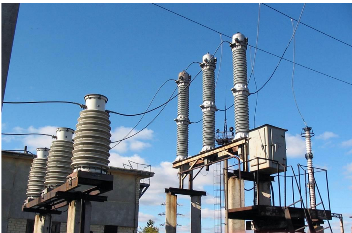
Рисунок 5.10 – Розташування вимірювальних трансформаторів струму типу ТФЗМ-110
