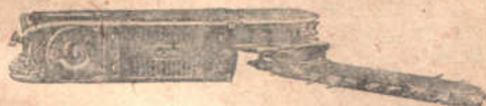
Тяжелая врубковая машина ленточная, типа Самсон
