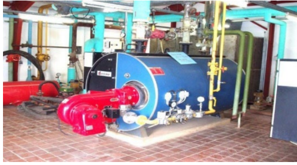
Fig. 3. Weishaupt VBN-630 boiler unit
