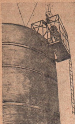
Рис. 177. Навеска комплектной люльки
