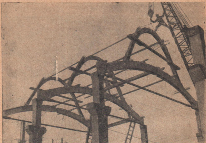
Рис. 206. Монтаж шарнирной железобетонной арки
