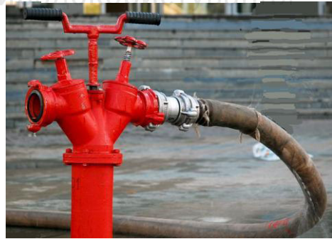
Рис. 2.13. Пожежний гідрант (ПГ) та стендер
