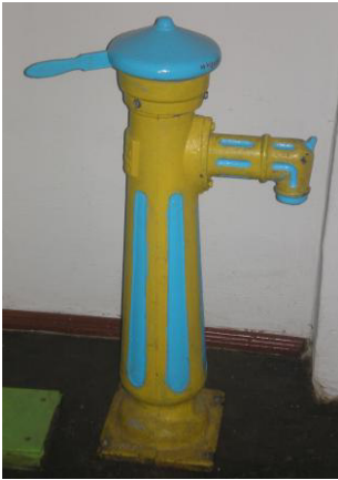
Рис. 2.11. Водорозбірна колонка ежекторного типу:
