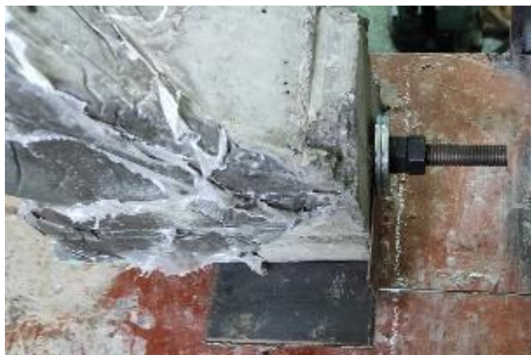
Рис. 2.6. Кріплення зтяжки на опорах арки
