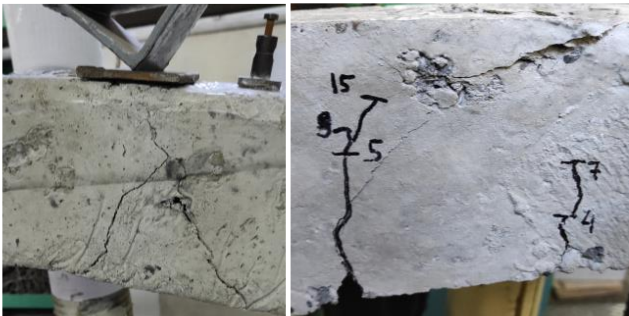
Рис. 3.7. Характер руйнування арки А1-1 та магістральна тріщина у її поясі
