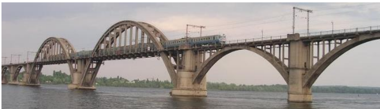
Рис. 1.3. Мерфо-Херсонський міст ( L=1610 м, 1932р.) через р. Дніпро в м. Дніпро
