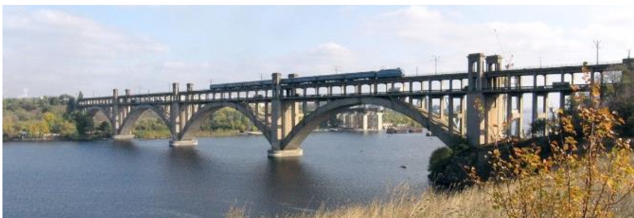
Рис. 1.4. Автомобільно-залізничний чотириарковий міст Преображенського ( L=228 м, 1952р.) через р. Дніпро в м. Запоріжжя
