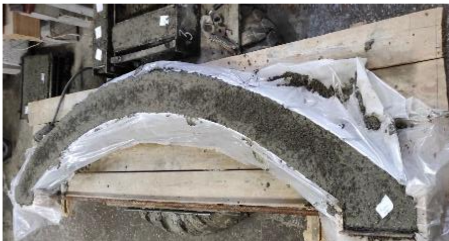
Рис. 2.8. Бетонування дослідних зразків арок
