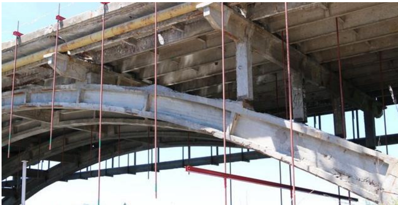
Рис. 1.2. Автомобільний Центральний міст ( L=129 м, 1956р.) через р. Південний Буг у м. Вінниця
