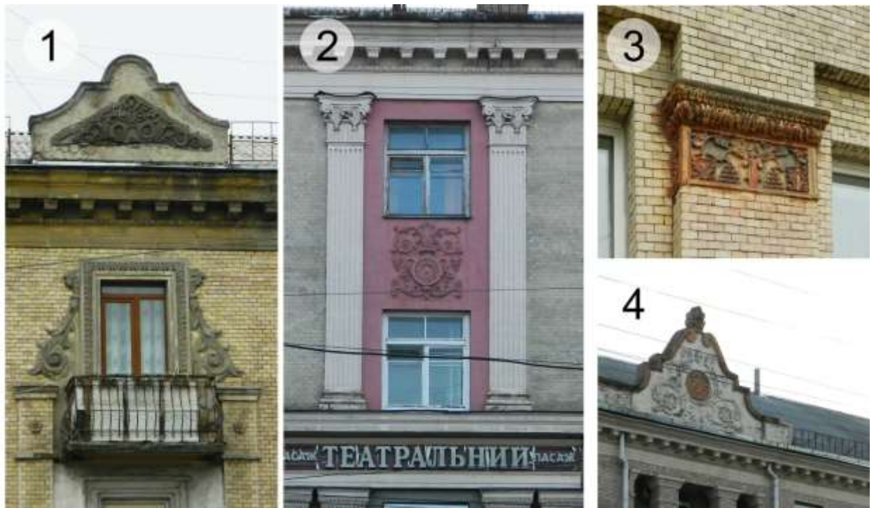
Рис. 4.1.3 Система стилістично подібних декоративних елементів на фасадах житлових будинків, Рівне, ансамбль Театральної площі (1 – вул.Соборна, 190, 2 – вул.Соборна, 156, 3 – вул.Соборна, 57, 4 – вул.Соборна, 61)
