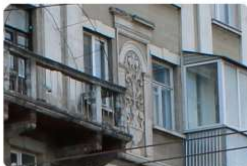
Житловий будинок, Тернопіль, вул.Руська, 29
