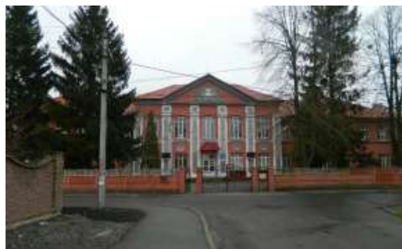
Школа №10, вул. Видумка, 26 (фото автора)
