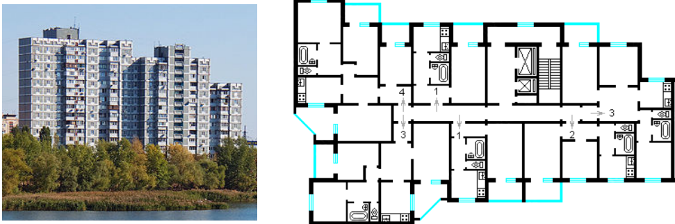
Рис. 5. Житловий будинок типової серії АПВС К-134: зовнішній вигляд та план типового поверху торцевої секції
