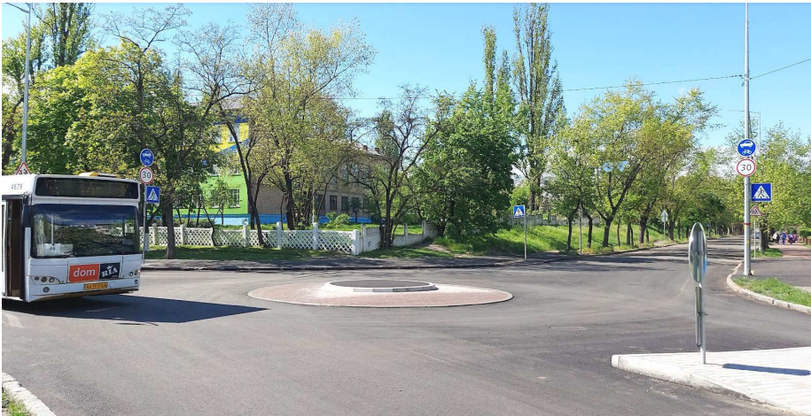
Рис. 6. Перехрестя вул. Ірини Бекешкіної і вул. Едуарда Вільде в м. Києві Фото: Тимофій Нагорний
