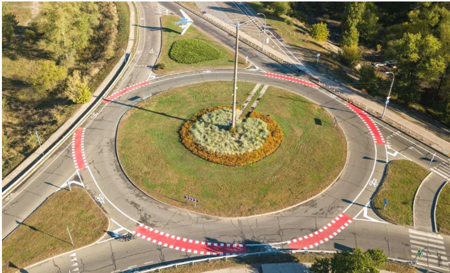
Рис. 7. Кільцева розв'язка на вул. Труханівській в м. Києві Фото: Bike City consulting
