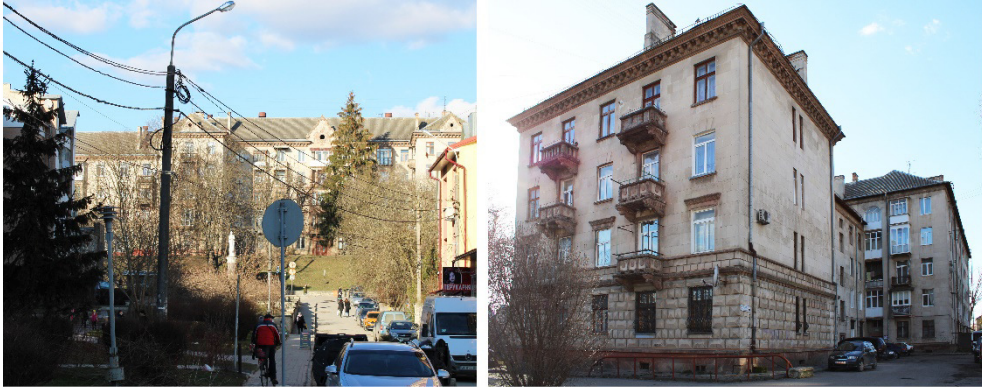
Рис. 1. Житловий будинок, Тернопіль, вул. Князя Острозького, 39/45
