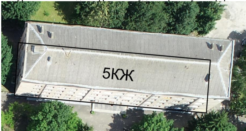
Рис. 4.1. Нанесення цоколя будівлі за двома видимими сторонами
