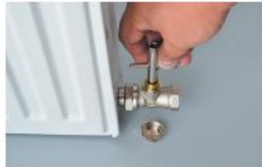
Рис. 18. Монтаж запірного клапану
