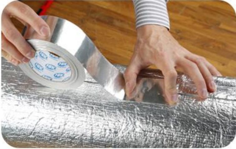
Рис. 35. Ізоляція зі спіненого поліетилену з фольгою
