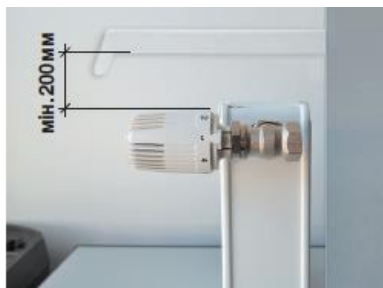
Рис. 11. Мінімальна відстань від конструкцій огороження
