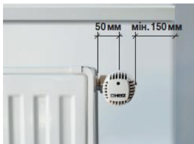
Рис. 11. Мінімальна відстань від конструкцій огороження
