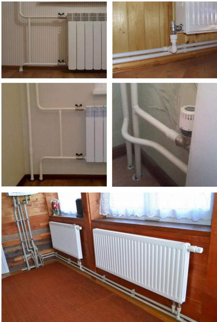
Рис. 33. Приєднання радіаторів до системи опалення
