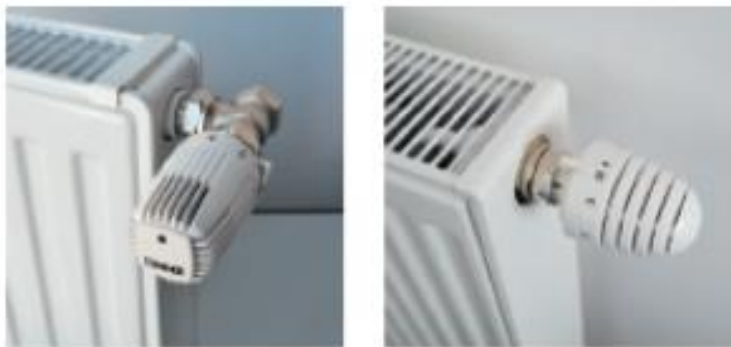
Рис. 8. Встановлення термостатичної головки безпосередньо на опалювальний прилад
