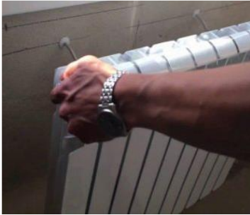
Рис. 30. Навішування опалювального приладу на кронштейни
