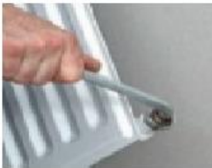
Рис. 18. Монтаж запірного клапану
