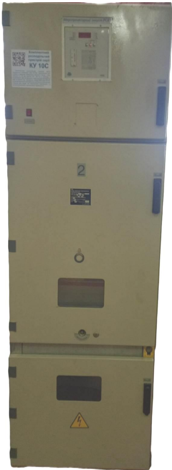
Рисунок 1.12 – Шафа типу ШВВ-10-20-01-630 в ауд. 509 (а), візок інвентарний (б), рукоятка переміщення висувного елемента (в), рукоятка для оперування заземлювачем (г)
