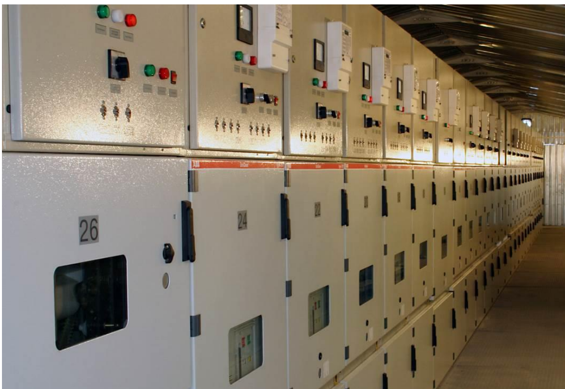
Рисунок 1.1 – Комплектний розподільчий пристрій КРП серії КУ 10С
