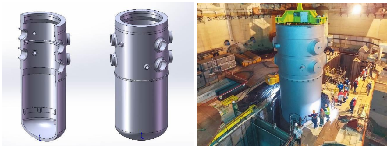
Рисунок 4.3 – Корпус реактора ВВЕР-1000 (а) та його монтаж (б)
