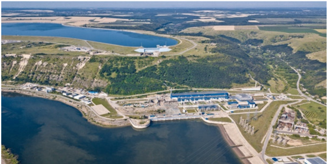
Рис. 1.5. Дністровська ГАЕС (вигляд зверху)
