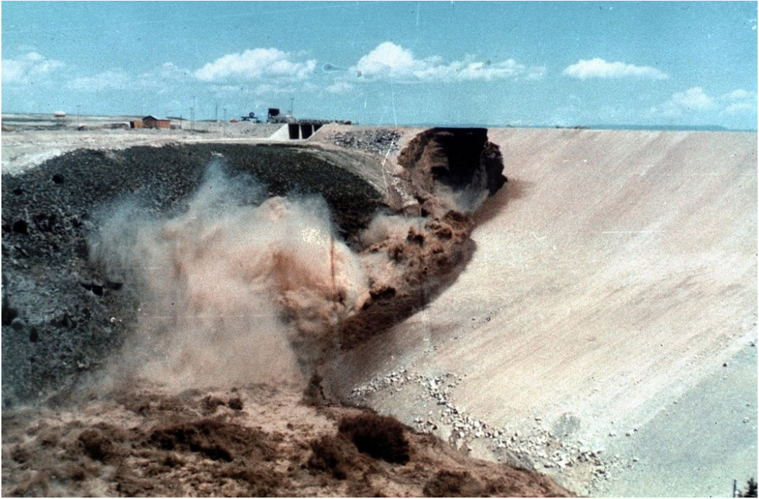
Рис. 3.26. Руйнування греблі Тітон: вигляд з нижнього б'єфу
