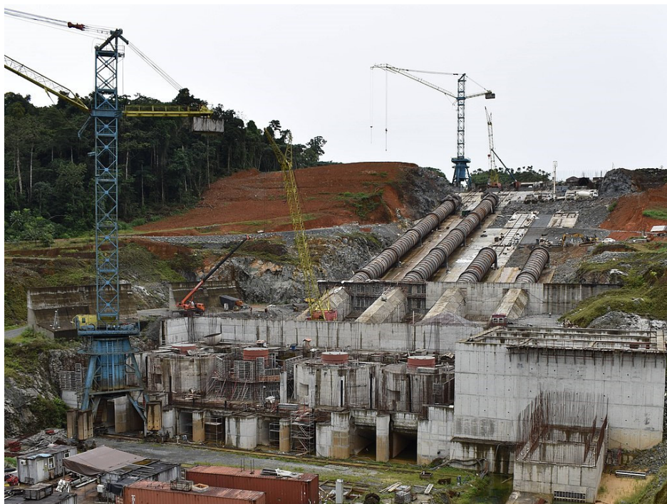
Рис. 3.24. Панорама будівництва ГЕС Сендже з металевими турбінними водоводами
