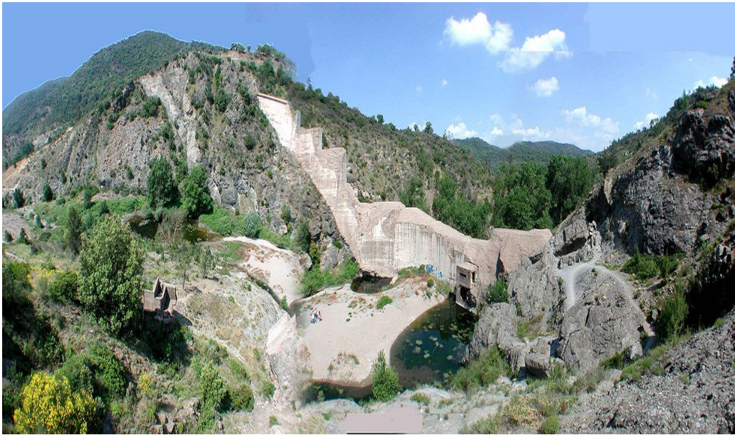
Рис. 3.28. Залишки греблі Мальпассе: вигляд з нижнього б'єфу (1988 р.)
