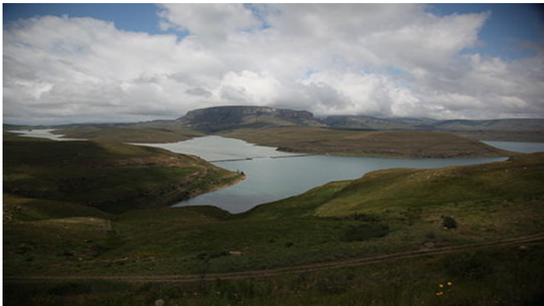
Рис. 1.4. ГАЕС Дракенсберг (вигляд на систему верхніх водоймищ)
