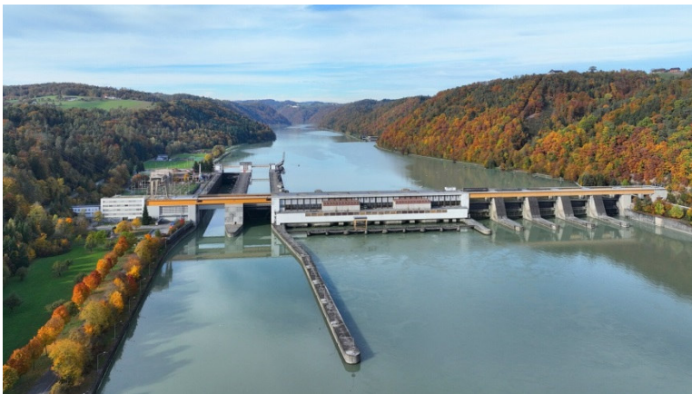
Рис. 3.22. ГЕС Ашах напіввідкритого типу: вигляд з верхнього б'єфу
