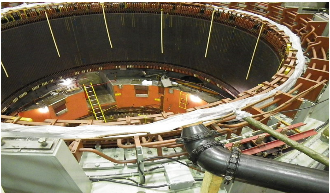
Рис. 2.31. ГЕС Черчилл Фоллс, ремонт турбіни
