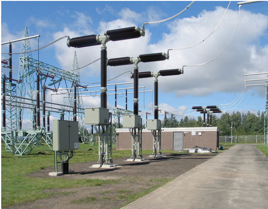
Рис. 4.15. Відкритий трьохполюсний елегазовий вимикач потужністю 400 кВ
