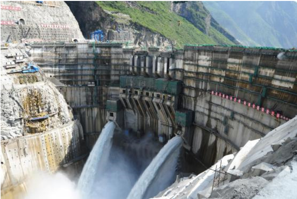
Рис. 3.1. Вигляд з нижнього б'єфу греблі Цзінпін-1 під час будівництва
