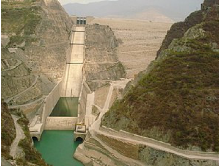
Рис. 3.15. Гідровузол Техрі: вигляд з нижнього б'єфу
