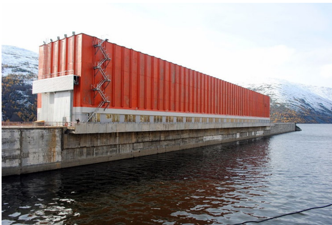
Рис. 2.34. Водоприймач Колимської ГЕС, вигляд з верхнього б'єфу
