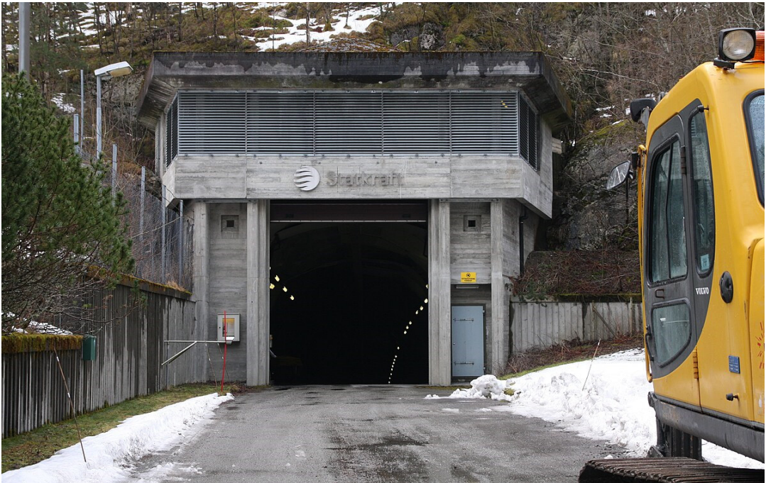
Рис. 2.18. Вигляд portalу напірного тунелю ГЕС Квілдел
