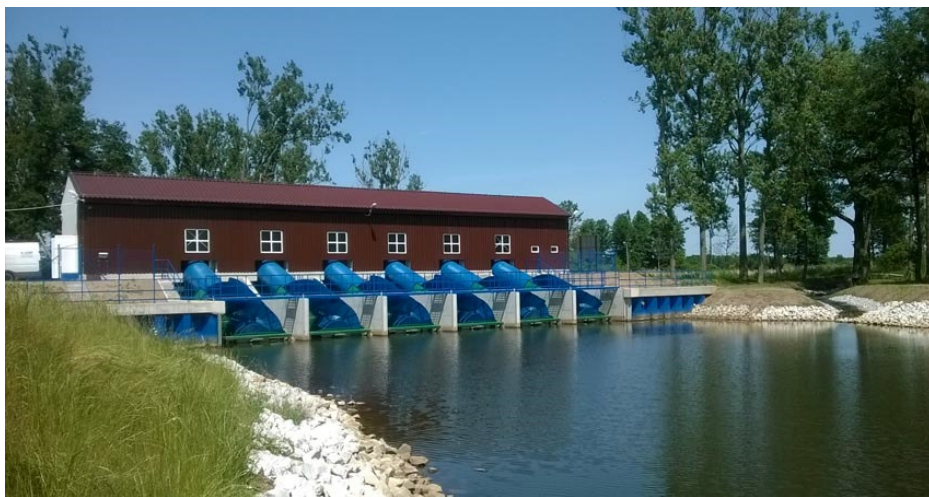
Рис. 24.10. Гідроелектростанція Rosko з шнековими турбінами (6 x ST 3250-4970 H=1,7 m; Q=4,5\text{m}^3\cdot\text{s}^{-1} ; N=360 (6x60) kW)
