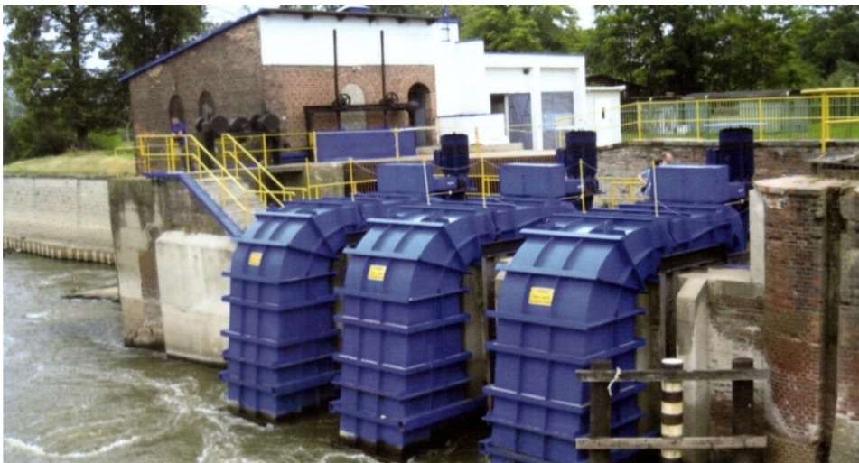
Рис. 24.5. Гідроелектростанція Olawa II (3 x TM10 Modular Micro H=4,0\text{ m} ; Q=11,7\text{ m}^3\cdot\text{s}^{-1} ; N=300\text{ kW} )
