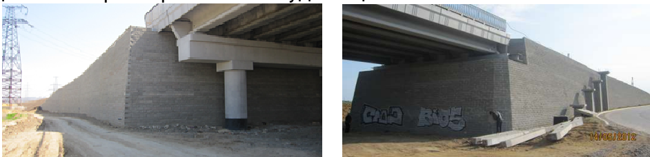
Рис. 4. Підпірні стіни з армуванням ґрунту георешітками
