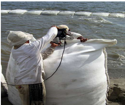
Рис. 9. Використання геобегів для виготовлення хвилеломів
