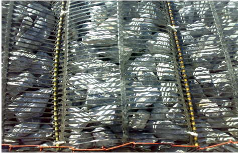
Рис. 7. Конструкції матраців з одновісних жорстких решіток
