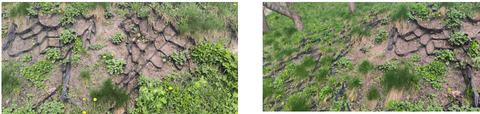
Рис. 10. Негативні випадки застосування геосіток при кріпленні укосу схилу
