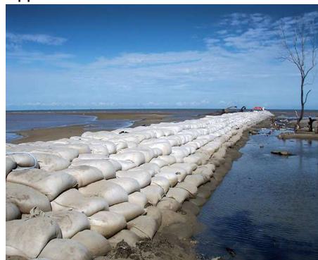
Рис. 9. Використання геобегів для виготовлення хвилеломів
