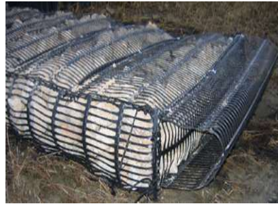
Рис. 7. Конструкції матраців з одновісних жорстких решіток
