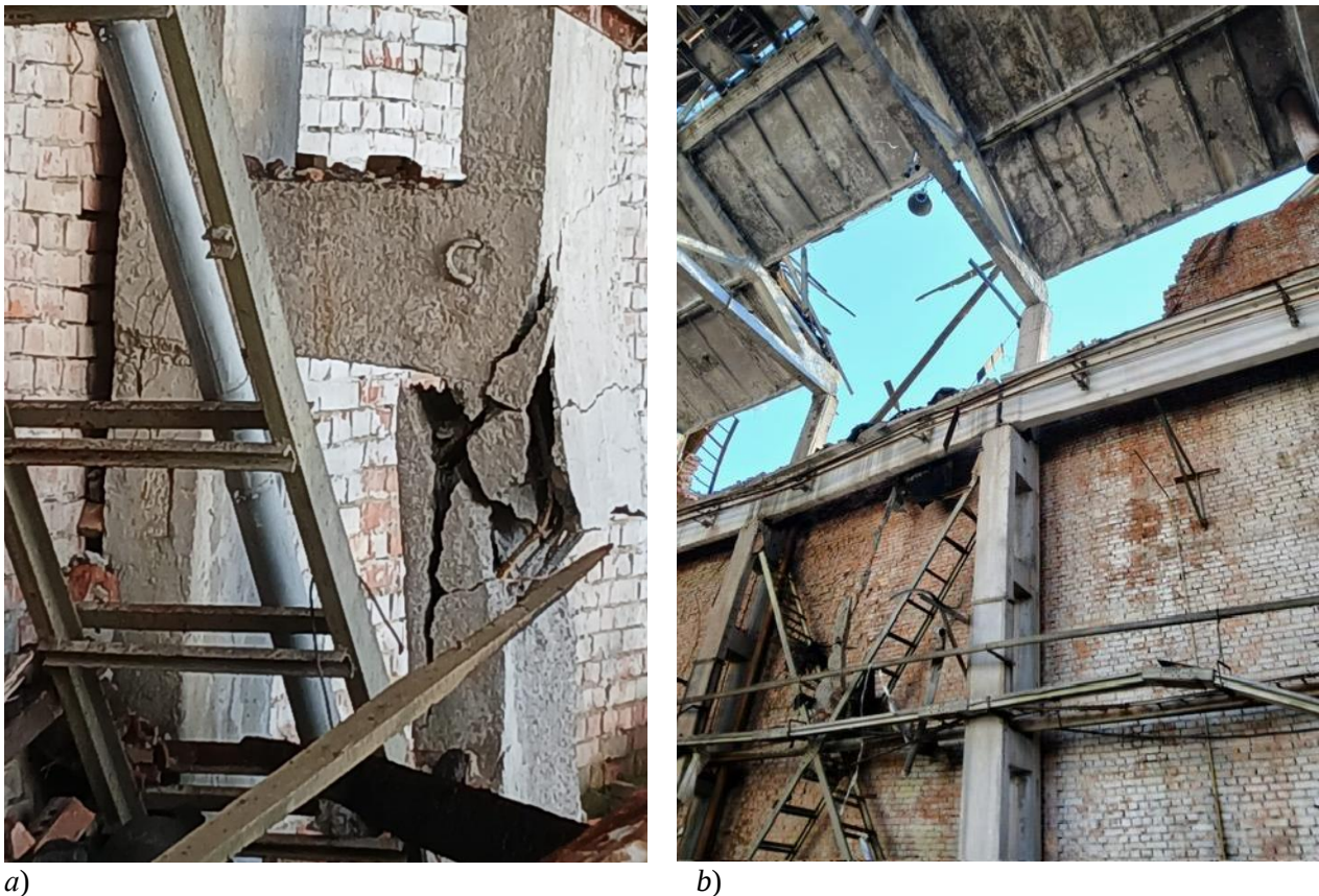
Рис. 1. Руйнування підкранової гілки: а) надкранової частини; б) двогілкової колони горизонтальною повітряною ударною хвилею
