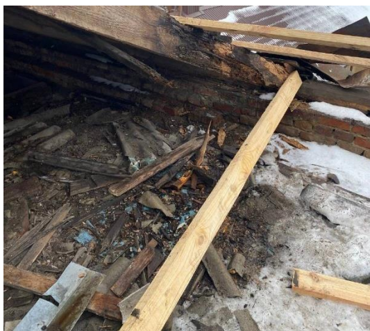
Рис. 3. Гниття деревини
