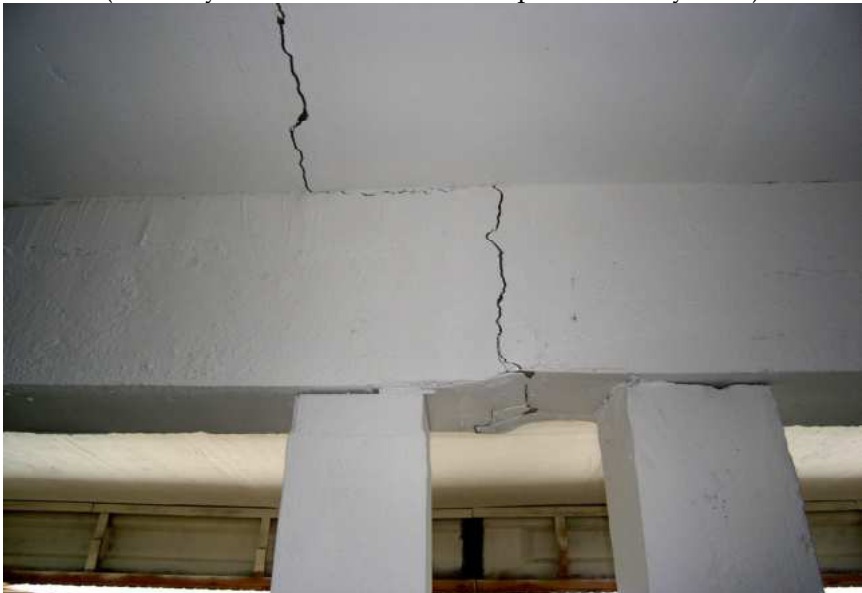
Розвиток осадочних тріщин в несучих конструкціях внаслідок неправильного влаштування вертикального деформаційного шва (м. Славути Хмельницької обл., промислова будівля)
