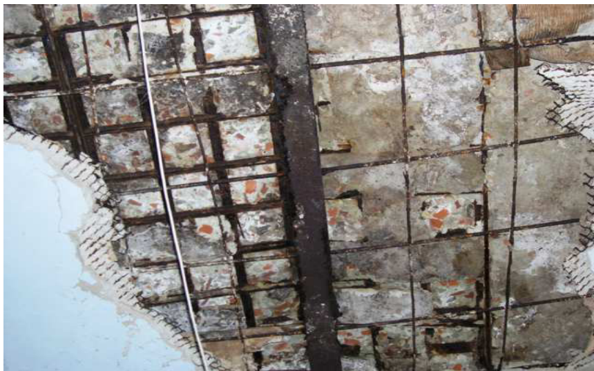
Руйнування захисного шару бетону, оголення і корозія робочої арматури монолітного перекриття внаслідок систематичного просочування вологою (м. Львів, універмаг на пл. Ринок)
