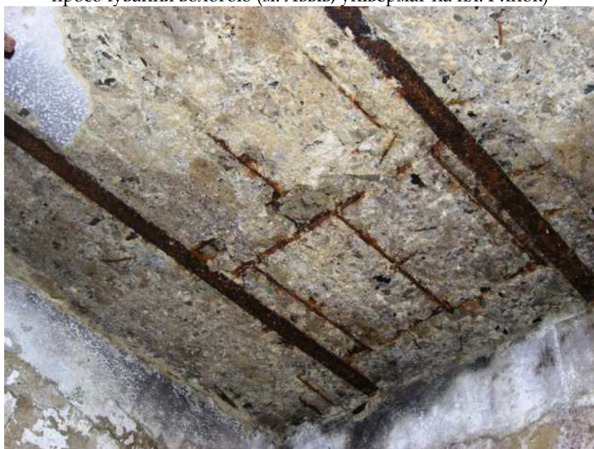
Руйнування захисного шару бетону, оголення і корозія робочої арматури монолітного перекриття внаслідок систематичного просочування вологою (м. Львів, універмаг на пл. Ринок)
