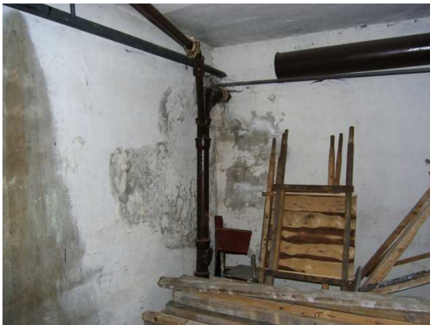
Фото 2.14, 2.15. Замочування стін ФПЧ водою з водопровідних комункацій
