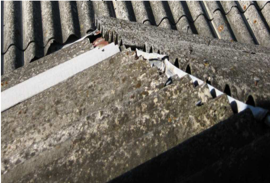
Технологічні дефекти при влаштуванні шиферної покрівлі: зверху – примикання дерев'яних карнизів у різних рівнях; внизу – відсутність конька в центральній частині покрівлі (м. Здолбунів Рівненського р-ну, будівля загальноосвітньої школи)
