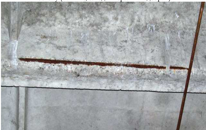
Руйнування захисного шару бетону, корозія арматури внаслідок впливу «кислотних дощів» (фото зверху); оголення робочої арматури внаслідок механічного руйнування захисного шару бетону (м. Рівне, завод мінеральних добрив)
