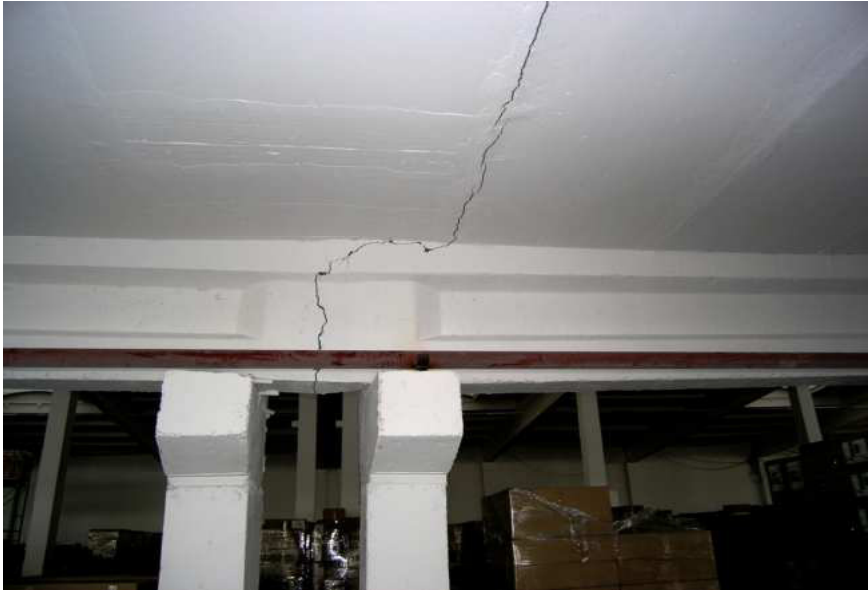
Розвиток осадочних тріщин в несучих конструкціях внаслідок неправильного влаштування вертикального деформаційного шва (м. Славути Хмельницької обл., промислова будівля)
