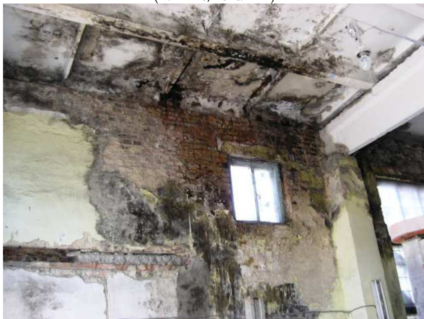
Замокання, ураження цвіллю плит покриття і зовнішніх стін внаслідок масового протікання руберойдової покрівлі (м. Рівне, котельня)
