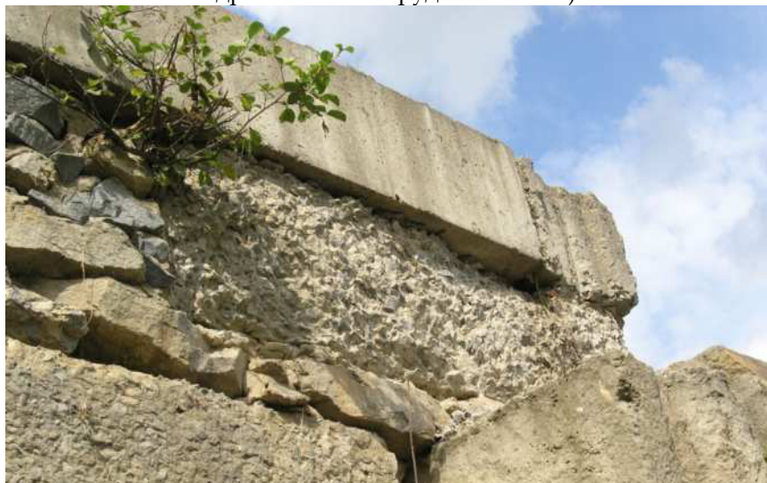
Руйнування монолітного бутобетонного (фото зверху) і збірного бетонного (фото внизу) бокових устоїв ГЕС внаслідок використання бетону низької марки (м. Баранівка Житомирської обл., гідротехнічна споруда малої ГЕС)
