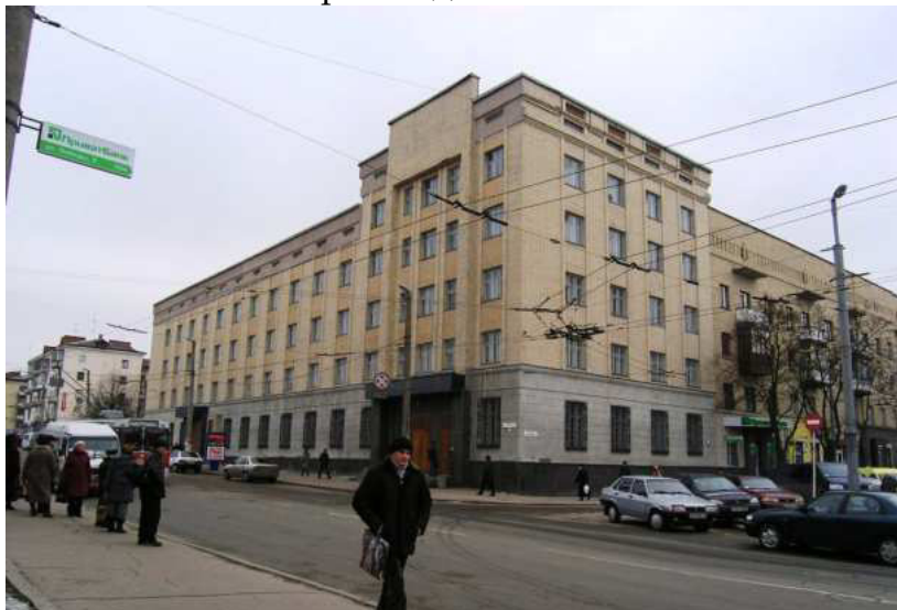
Фото 2.1. Головний фасад досліджуваної будівлі
