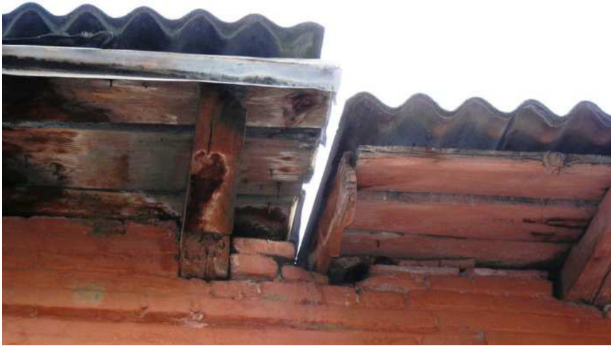
Технологічні дефекти при влаштуванні шиферної покрівлі: зверху – примикання дерев'яних карнизів у різних рівнях; внизу – відсутність конька в центральній частині покрівлі (м. Здолбунів Рівненського р-ну, будівля загальноосвітньої школи)
