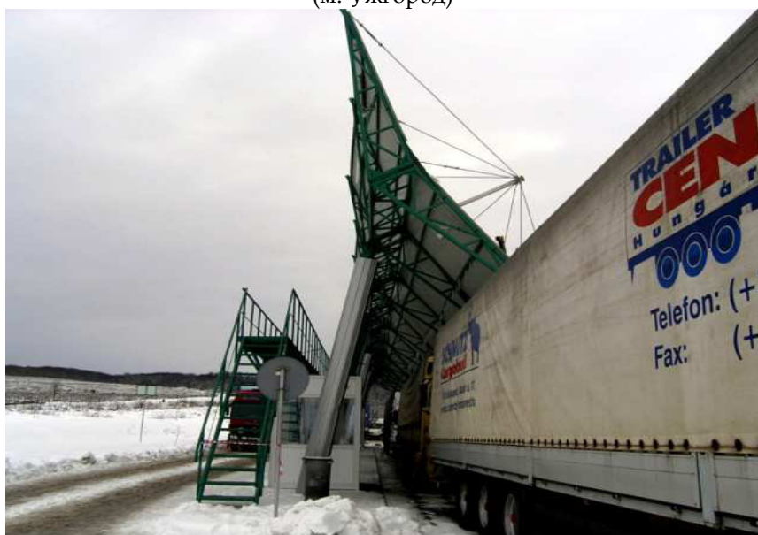
Аварія покриття КПП «Ужгород» внаслідок недостатньої просторової жорсткості металевих несучих конструкцій (м. Ужгород)
