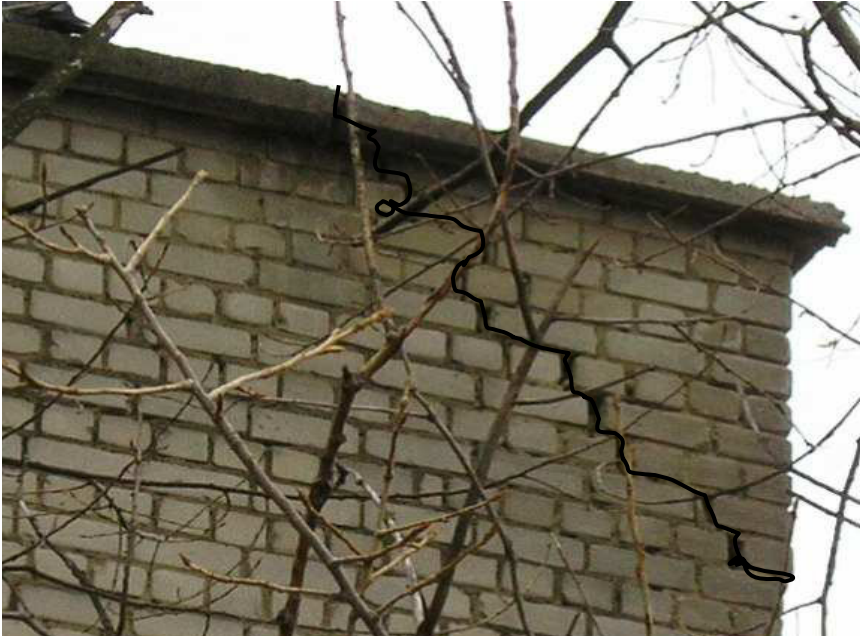
Тріщини зсуву в кладці парапету від нагрівання покриття (м. Рівне, гуртожиток)
