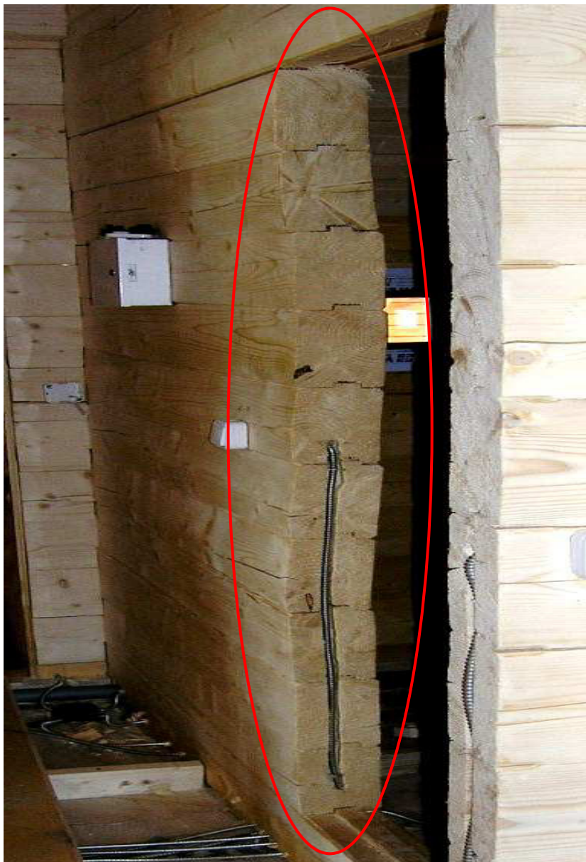
Викривлення несучої стіни з брусів внаслідок втрати стійкості (с. Світязь Волинської області, будинок відпочинку)
