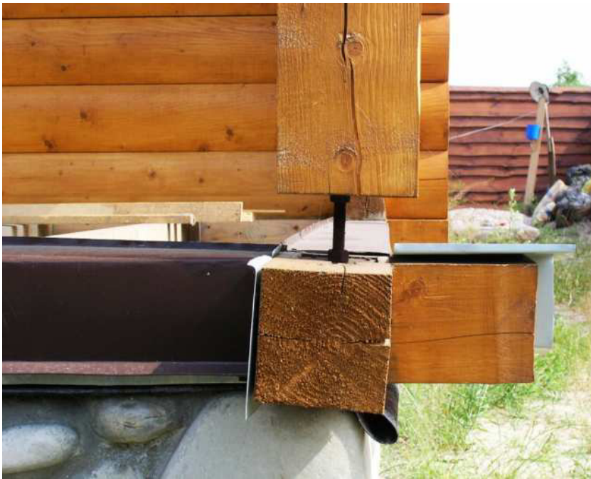
Технологічні дефекти влаштування опорних вузлів дерев'яних конструкцій (с. Світязь Волинської області, будинок відпочинку)
