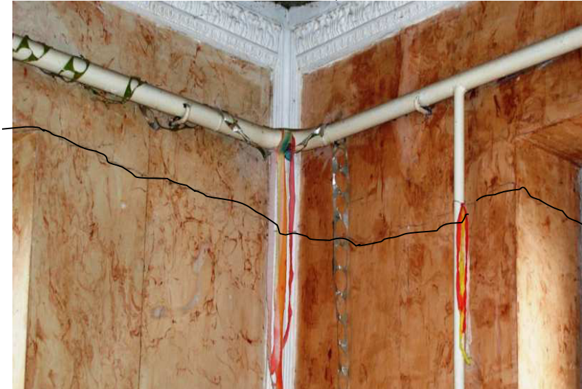
Наскрізні тріщини у зовнішніх стінах внаслідок просідання ґрунтової основи (зверху) та внаслідок розпірної дії перемищок (внизу) (с. Рачин Дубнівського р-ну Рівненської області, оздоровчий комплекс)
