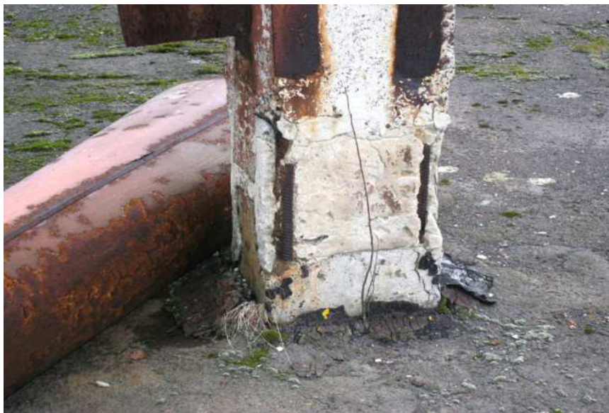
Руйнування захисного шару бетону, корозія арматури внаслідок впливу «кислотних дощів» (фото зверху); оголення робочої арматури внаслідок механічного руйнування захисного шару бетону (м. Рівне, завод мінеральних добрив)
