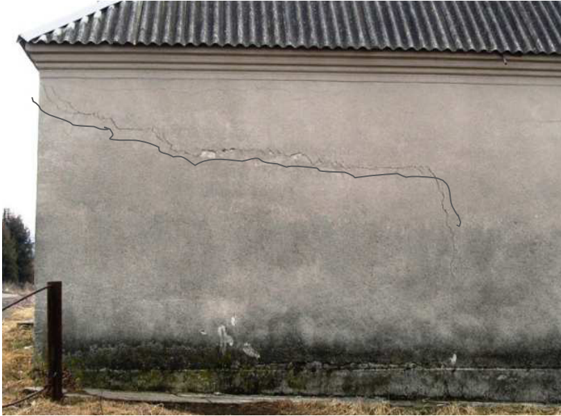
Наскрізні тріщини у зовнішніх стінах внаслідок просідання ґрунтової основи (зверху) та внаслідок розпірної дії перемищок (внизу) (с. Рачин Дубнівського р-ну Рівненської області, оздоровчий комплекс)
