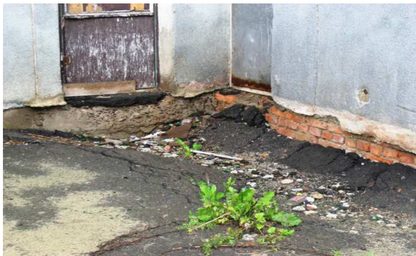
Руїнування асфальтобетонної відмостки внаслідок консолідації ґрунту зворотної засипки котловану (м. Дубно Рівненського району, будівля кінотеатру)
