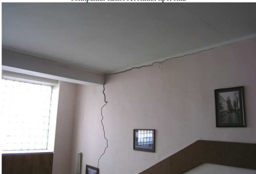
Фото 2.8, 2.9. Силлові тріщини у внутрішніх несучих стінах та в місцях обпирання залізобетонних прогонів
