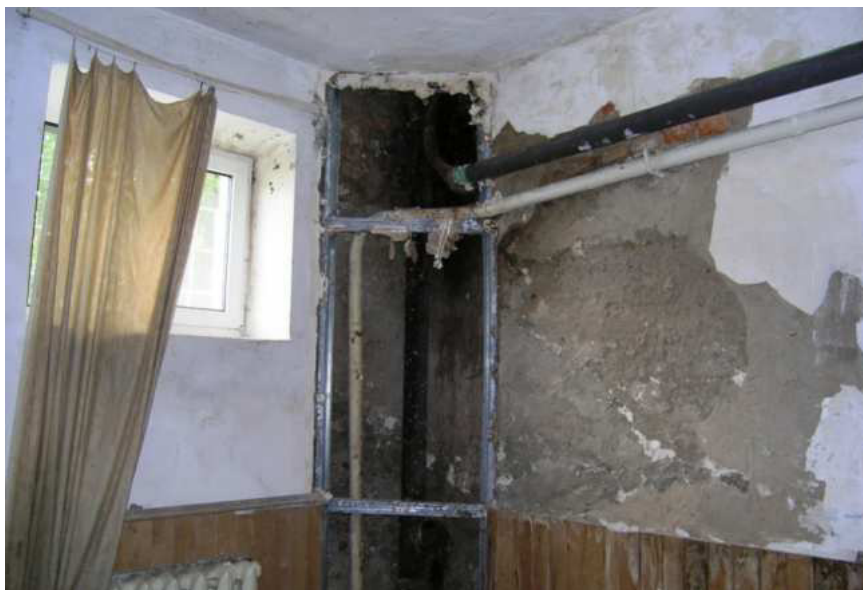
Фото 2.4, 2.5. Замокання стін цокольно-підвального поверху водою з відмостки, ураження грибком цегляної кладки
