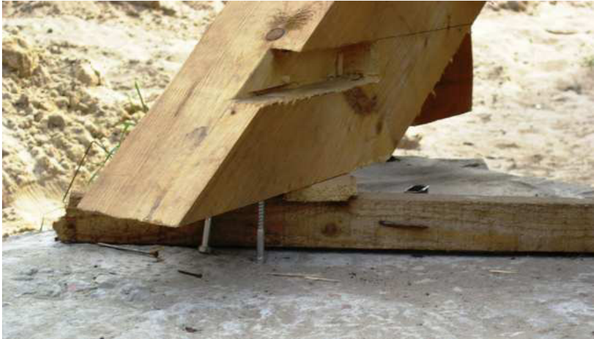
Технологічні дефекти влаштування опорних вузлів дерев'яних конструкцій (с. Світязь Волинської області, будинок відпочинку)
