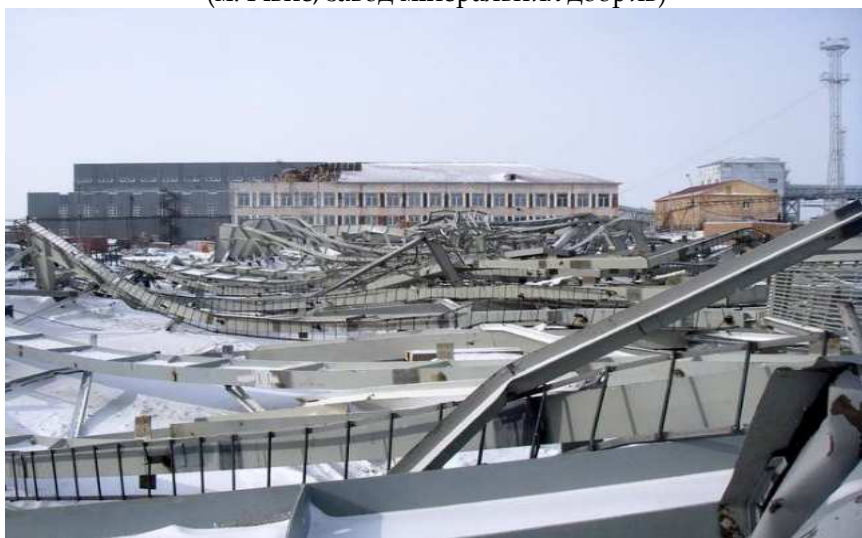
Аварія металевих несучих конструкцій торгово-розважального комплексу внаслідок стихійних сил природи (матеріали WWW.ndpi.kiev.ua)
