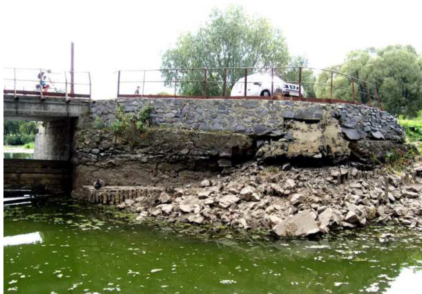
Руйнування монолітного бутобетонного (фото зверху) і збірного бетонного (фото внизу) бокових устоїв ГЕС внаслідок використання бетону низької марки (м. Баранівка Житомирської обл., гідротехнічна споруда малої ГЕС)
