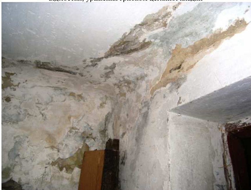
Фото 2.4, 2.5. Замокання стін цокольно-підвального поверху водою з відмостки, ураження грибком цегляної кладки
