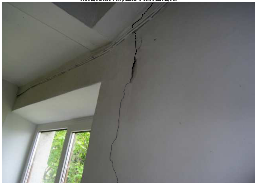
Фото 2.6, 2.7. Силлові тріщини в опорних зонах збірних залізобетонних сходових маршів і площадок
