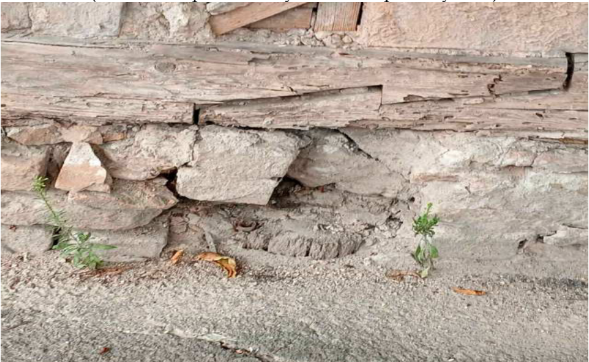
Виключення з роботи дерев'яної палі внаслідок «від'ємного» тертя ґрунту по її боковій поверхні (м. Рівне, дерев'яний будинок старої забудови)
