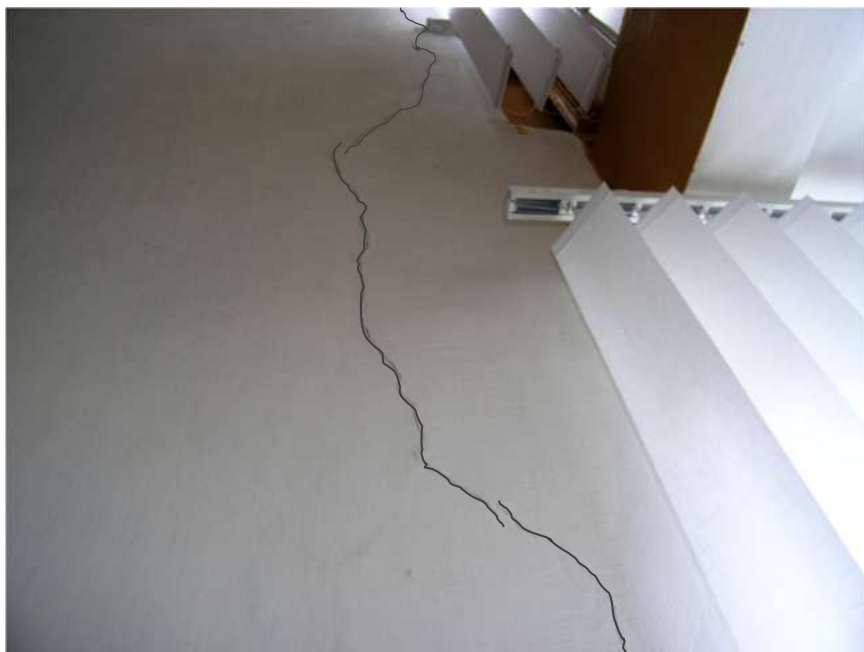
Фото 2.8, 2.9. Силлові тріщини у внутрішніх несучих стінах та в місцях обпирання залізобетонних прогонів
