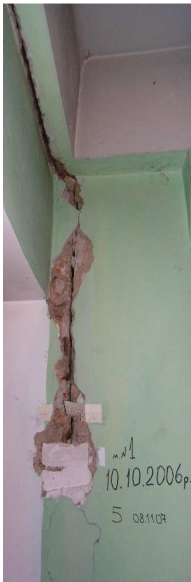
Тріщини між несучими елементами залізобетонного каркасу внаслідок неефективної роботи металевих вертикальних діафрагм жорсткості (м. Рівне, будівля обласного архіву)
