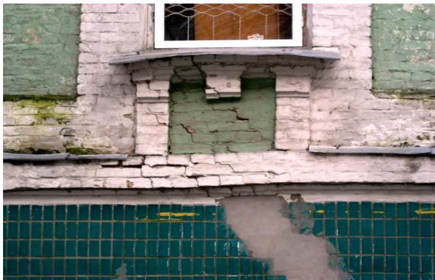
Сильні похилі тріщини у зовнішніх несучих стінах внаслідок нерівномірних деформацій ґрунтової основи (м. Київ, адміністративна будівля)
