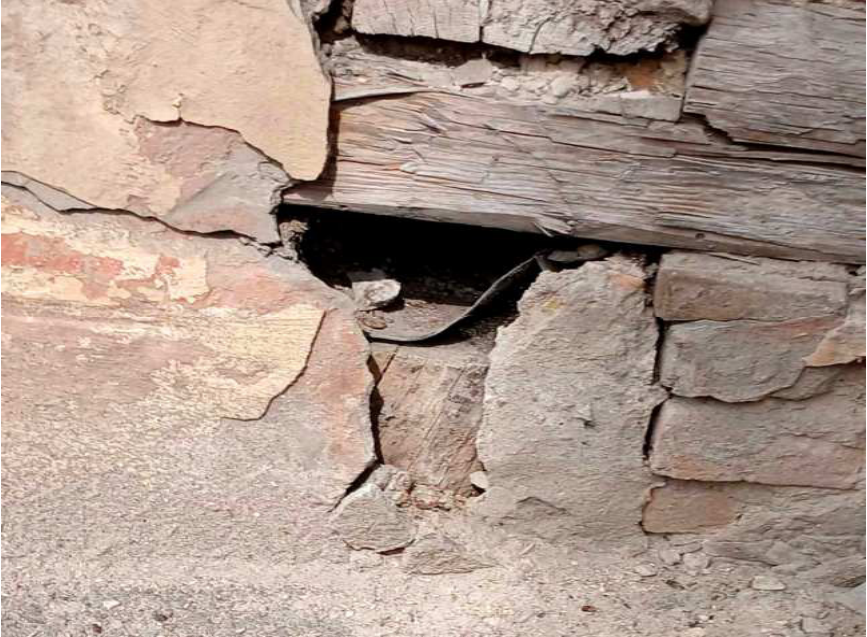
Виключення з роботи дерев'яної палі внаслідок «від'ємного» тертя ґрунту по її боковій поверхні (м. Рівне, дерев'яний будинок старої забудови)
