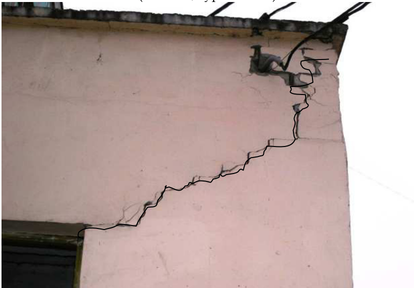
Тріщини зсуву в кладці парапету від нагрівання покриття (м. Рівне, гуртожиток)
