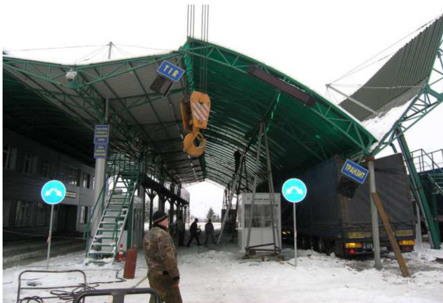
Аварія покриття КПП «Ужгород» внаслідок недостатньої просторової жорсткості металевих несучих конструкцій (м. Ужгород)
