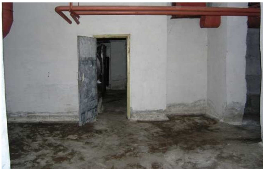
Фото 2.14, 2.15. Замочування стін ФПЧ водою з водопровідних комункацій
