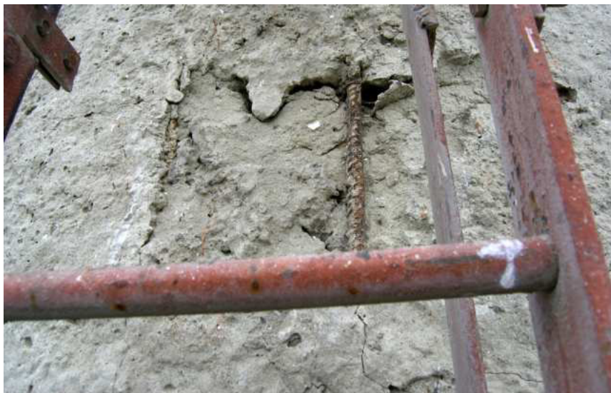
Оголення робочої арматури внаслідок технологічного браку (фото зверху); шелушіння (вивітрювання) бетону внаслідок циклічного впливу замокання-замерзання-відтаювання (фото внизу) (смт Квасилів Рівненського району, промислова димова труба)
