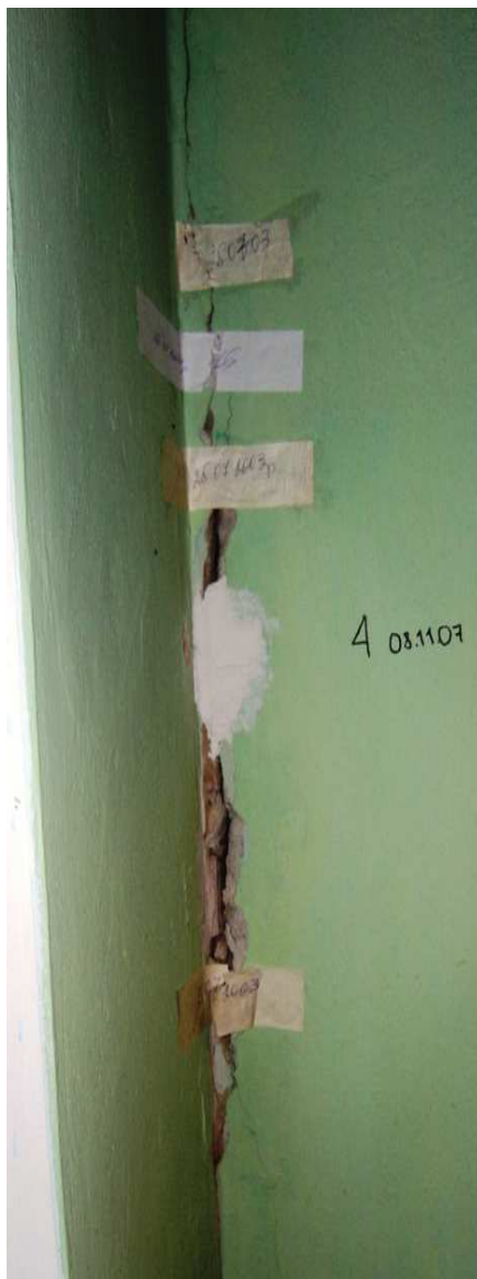
Тріщини між несучими елементами залізобетонного каркасу внаслідок неефективної роботи металевих вертикальних діафрагм жорсткості (м. Рівне, будівля обласного архіву)
