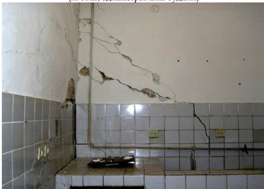
Сильні похилі тріщини у зовнішніх несучих стінах внаслідок нерівномірних деформацій ґрунтової основи (м. Київ, адміністративна будівля)
