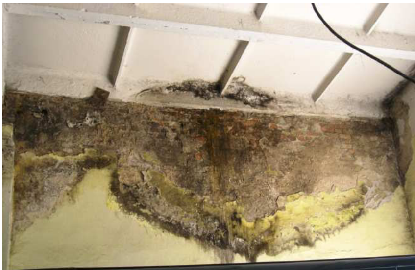
Замокання, ураження цвіллю плит покриття і зовнішніх стін внаслідок масового протікання руберойдової покрівлі (м. Рівне, котельня)
