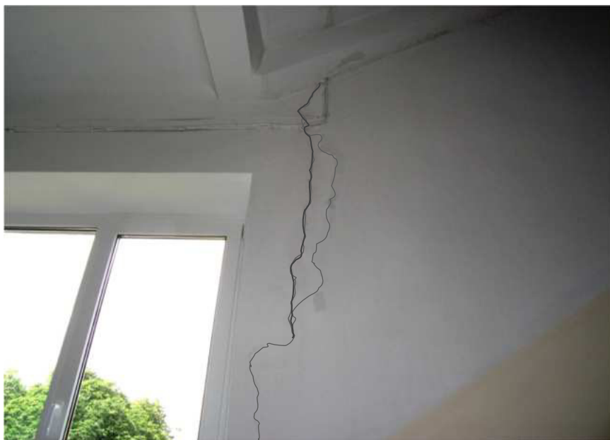
Фото 2.6, 2.7. Силлові тріщини в опорних зонах збірних залізобетонних сходових маршів і площадок
