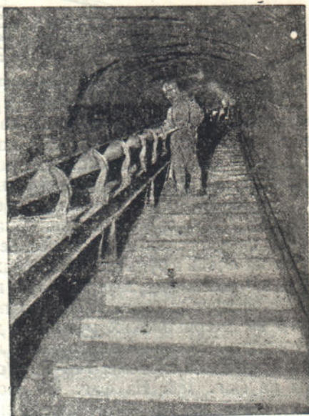
Фиг. 189. Вид на конвейер, доставляющий уголь по наклонной шахте (Allen & Garsia).
