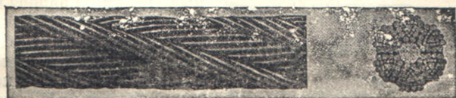
Фиг. 6. Канат двойной крутки с треугольными проволоками.
