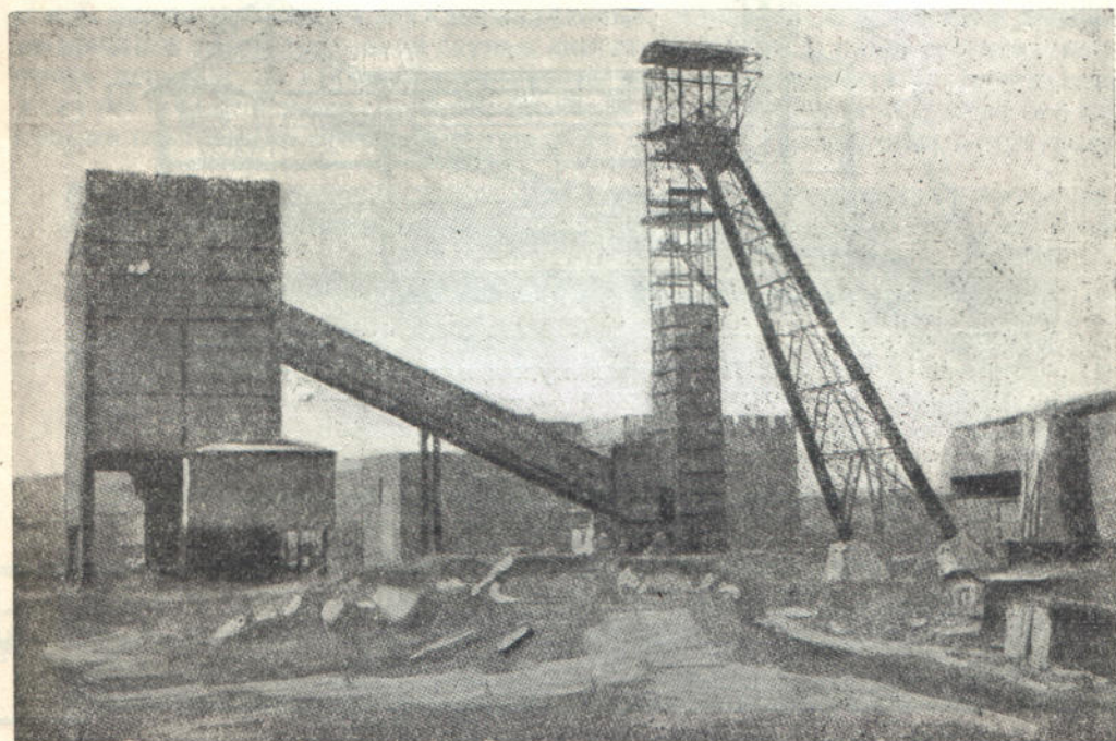
Фиг. 449. Подача на ленте угля от ствола бункера сортировки (Skip Compagnie).
