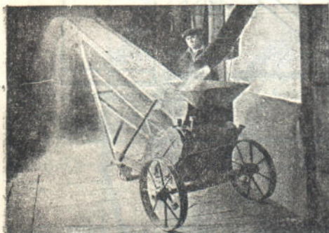
Фиг. 419. Передвижная вагонопгрузочная машина (Link-Belt).
