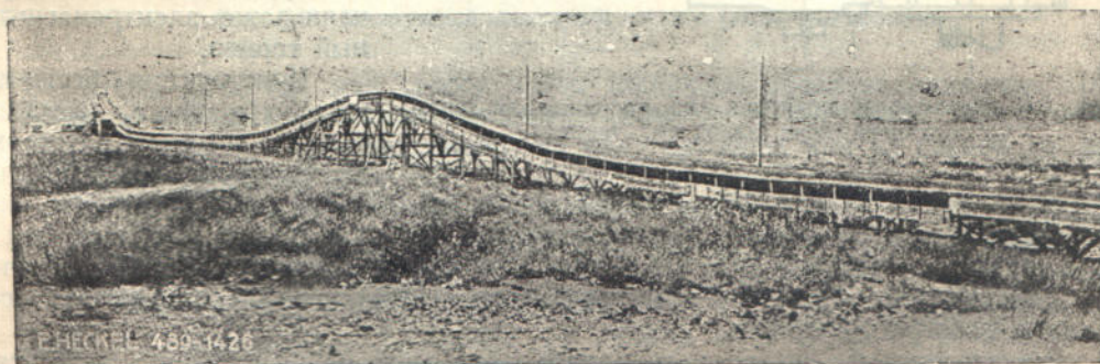
Фиг. 345. Шатер с поднятой серединой для пропуска дороги (Нескел).
