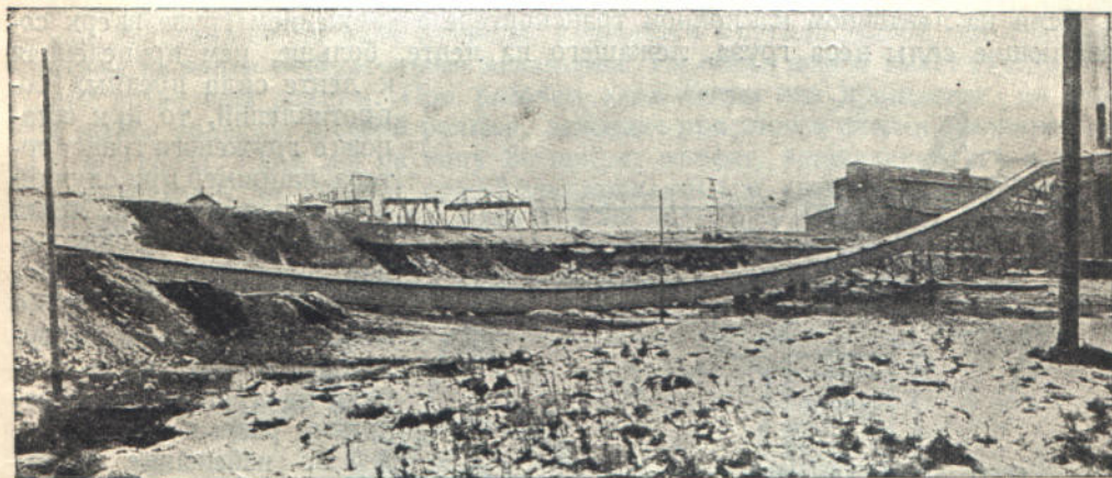
Фиг. 344. Установка ленточного конвейера в коридоре криволинейной формы (Нескел).
