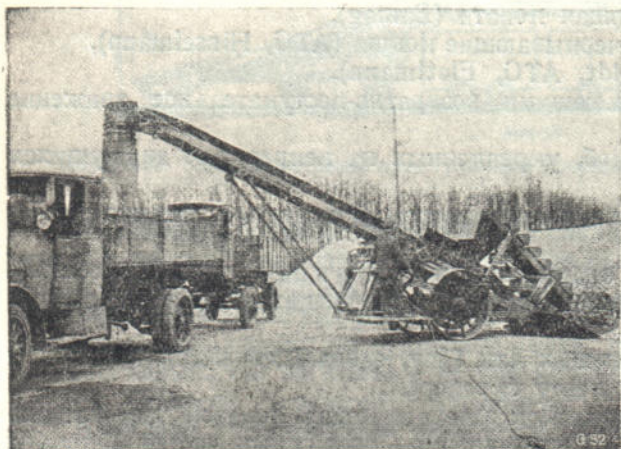
Фиг. 396. Механический грузчик АТГ.
