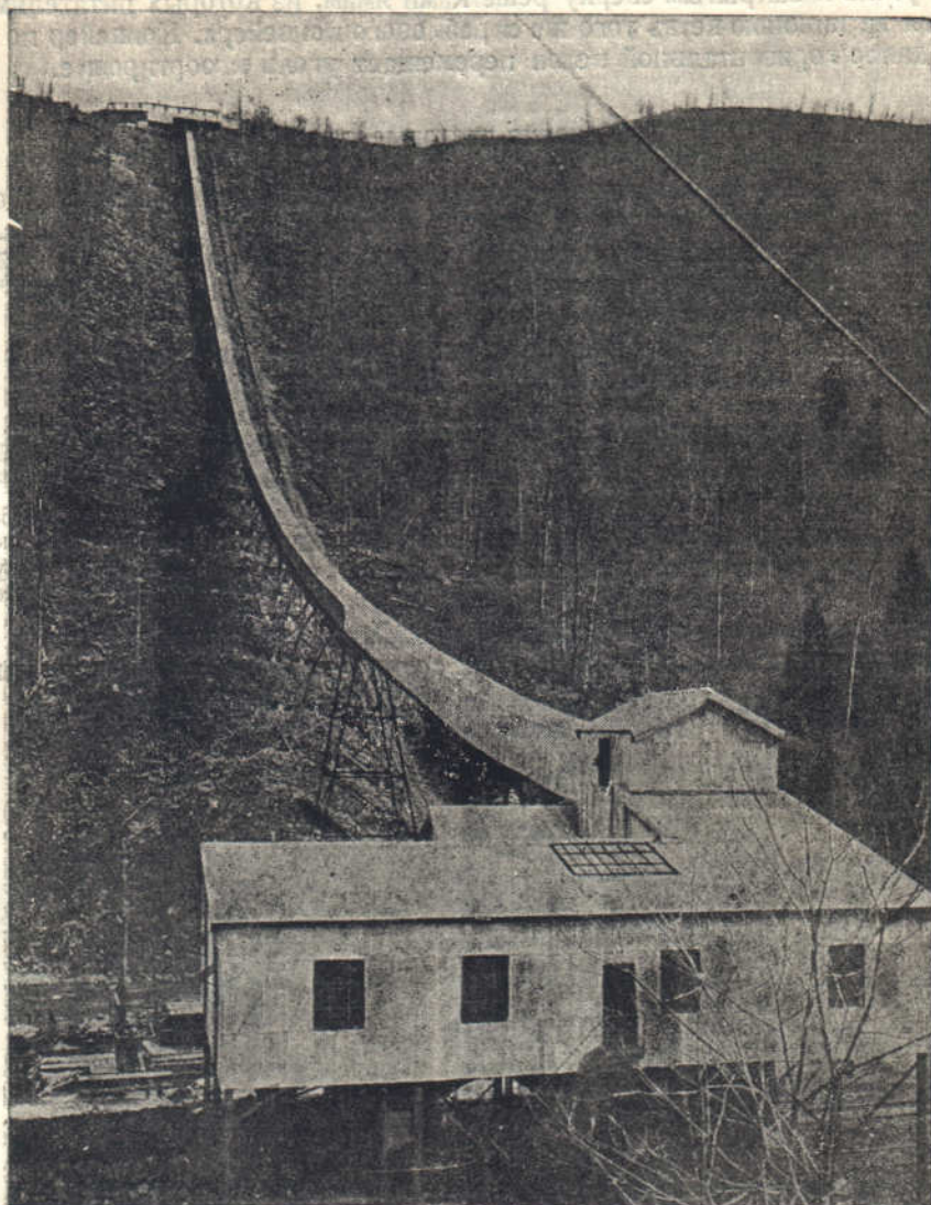
Фиг. 668. Канатно-дисковый конвейер длиной 495 м (Fairmont).
