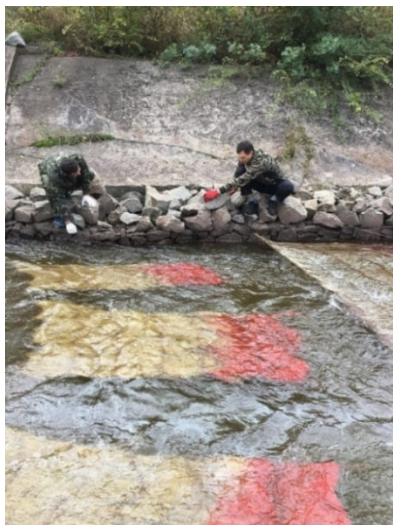
Рис. 9.4. Встановлення та монтаж у р. Капустянка стаціонарних конструкцій із волокнистим носієм типу «ВІА»
