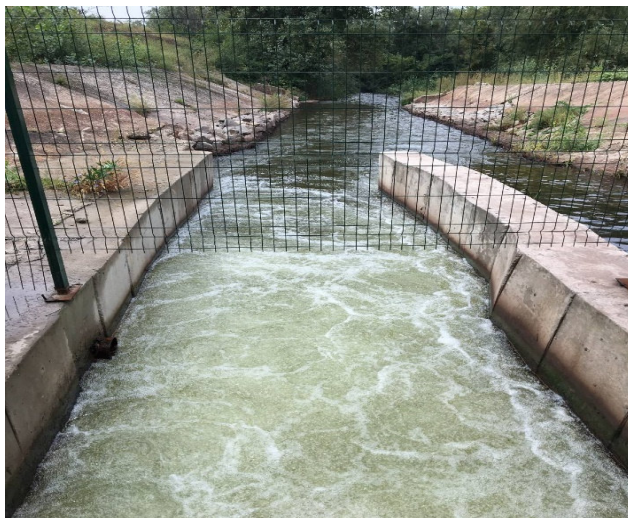
Рис. 9.2. Після міні-ГЕС промислові стічні води інтенсивно насичуються розчиненим киснем та потрапляють до р. Капустянка
