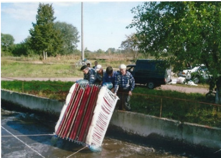
Рис. 9.14. Монтаж касети з «ВІЯми» в канал аеротенку
