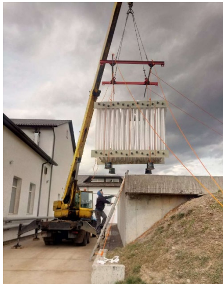
Рис. 9.16. Монтаж касети з «ВІЯми» в аеротенку ТзОВ «Світ шкіри» (м. Болехів)
