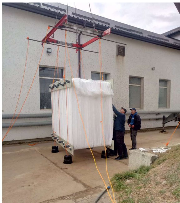
Рис. 9.19. Збірка касети з «ВІАми»
