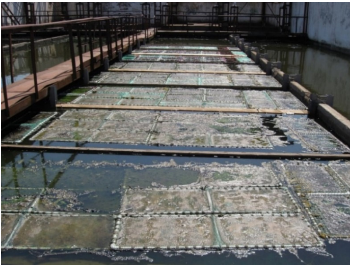
Рис. 8.4. Сімдесят шість змонтованих плотиків із волокнистим носієм «ВІЯ» встановлені в одному експериментальному відстійнику зливових очисних споруд заводу АТ «Мотор Січ» у 2017 р.
