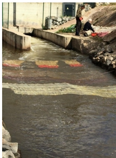
Рис. 9.4. Встановлення та монтаж у р. Капустянка стаціонарних конструкцій із волокнистим носієм типу «ВІА»
