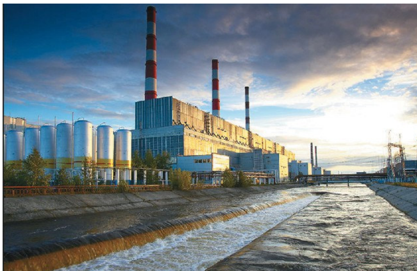
Рис. 6.3. Теплова електростанція (на передньому плані відкритий охолоджувальний басейн)
