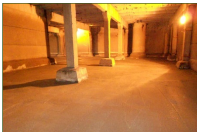
Рис. 2.10. Резервуари чистої води (РЧВ): види зовні та із середини
