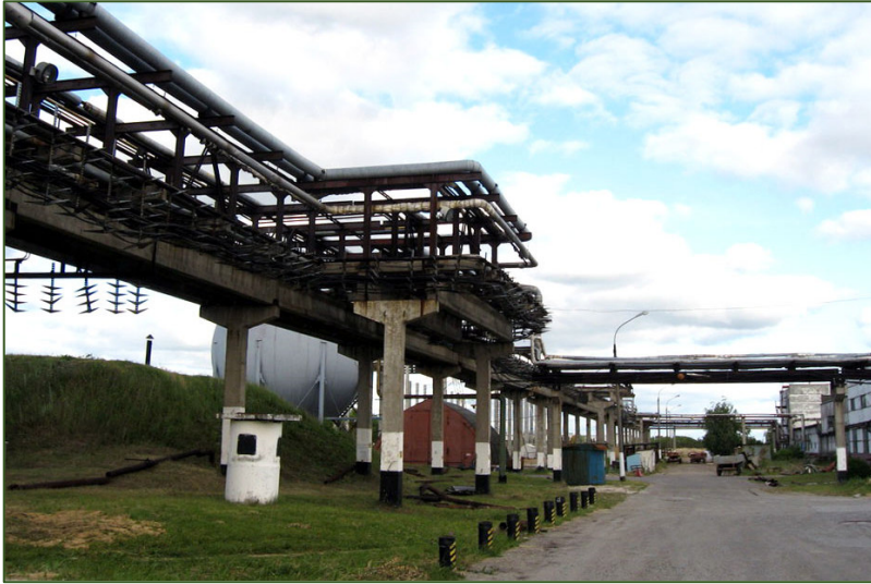
Рис. 5.5. Надземне прокладання мереж на високих опорах
