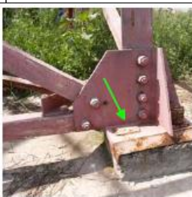
Рис. 15. Відсутність анкерного болта
