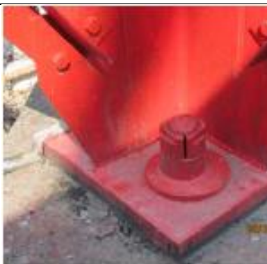
Рис. 14. Дефект гайки
