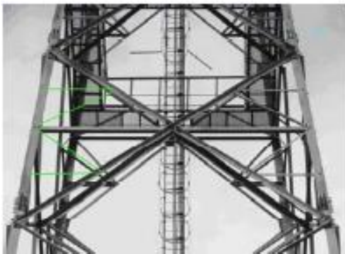
Рис. 17. Відсутність елементів решітки
