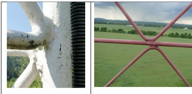
Рис. 26. Неспівосність елементів решітки стовбура щогли
