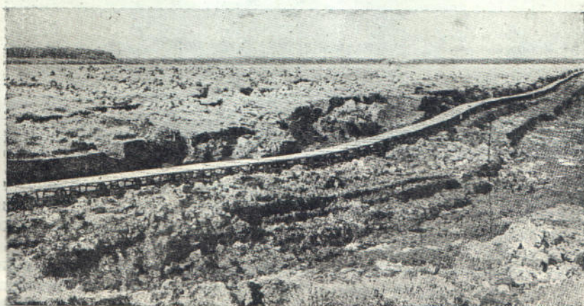
Фиг. 198. Конвейер длиной 1000 м с подвижными двигателями на торфоразработках (Weserhütte).
