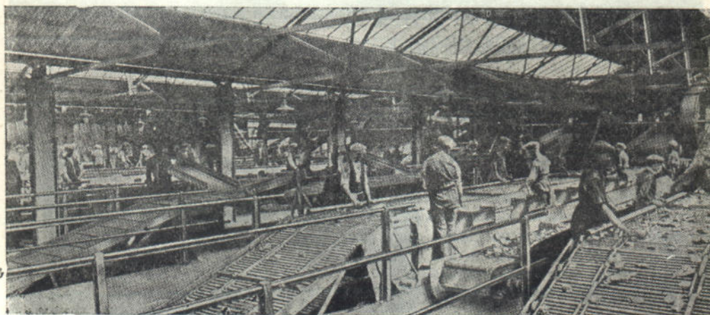
Фиг. 136. Породоотборный и погрузочный конвейер (Norton).
