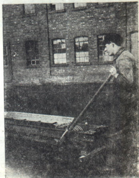
Фиг. 276. Натягивание ленты реечным натяжным устройством.
