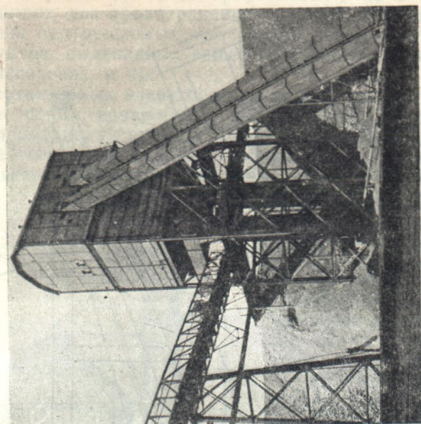
Фиг. 420. Наклонный элеватор опирающийся на колонны и кронштейны (Westfalia-Dinnendahl).
