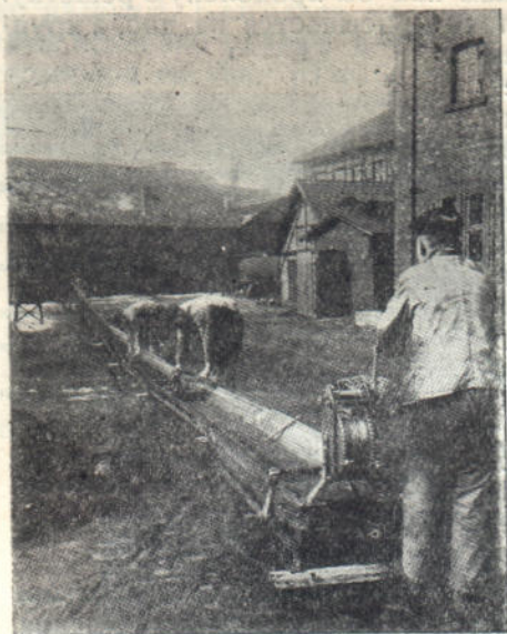
Фиг. 275. Протягивание ленты вспомогательной лебедкой.
