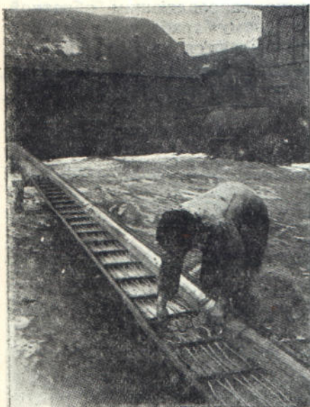
Фиг. 274. Соединение двух секций ленты на стыке.
