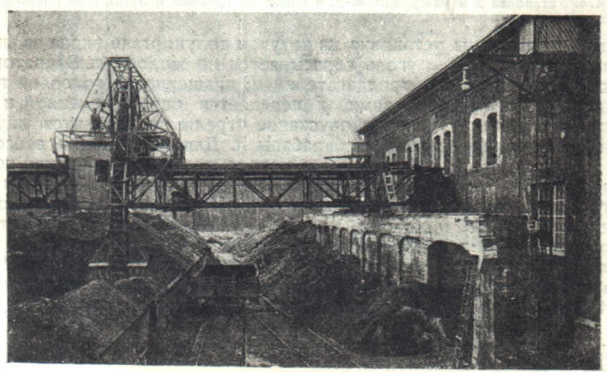
Фиг. 476. Общий вид склада, оборудованного мостом, с перегрузчиком Heinzelmann.
