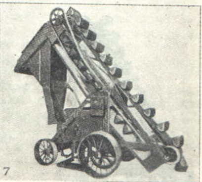
Фиг. 482. Типы американских элеваторных грузочных машин.
