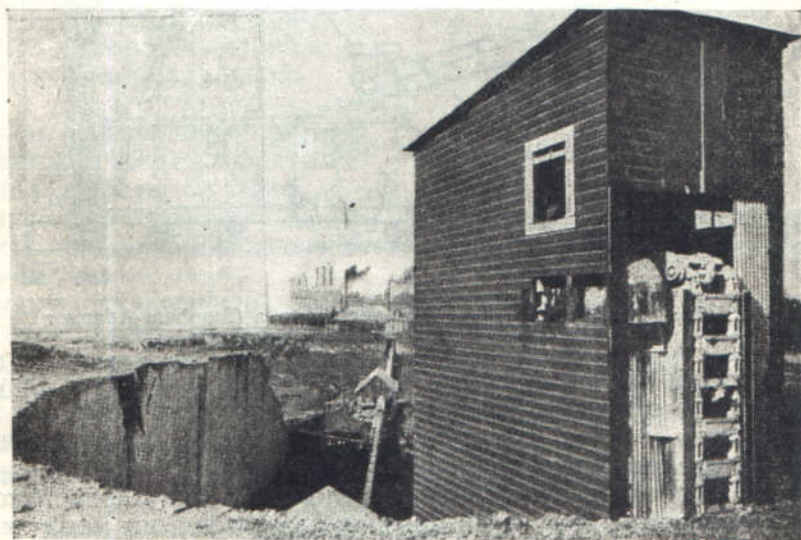
Фиг. 454. Разработка глубокого карьера с отвесными стенками Adel-экскаватором (Stephens-Adamson).
