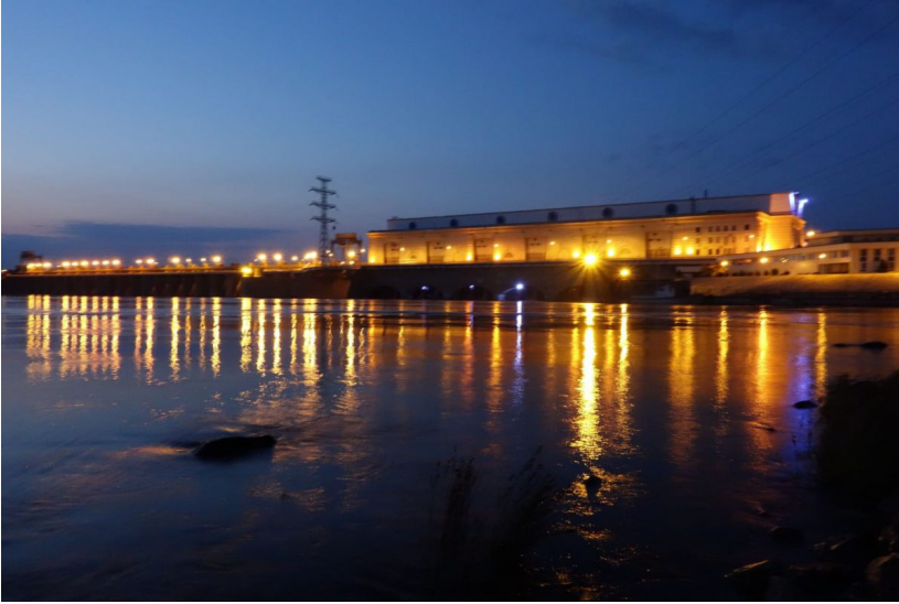
Рис. 6.14. Каховська ГЕС (потужність – 351 МВт. – зруйнована окупантами у 2023 році)
