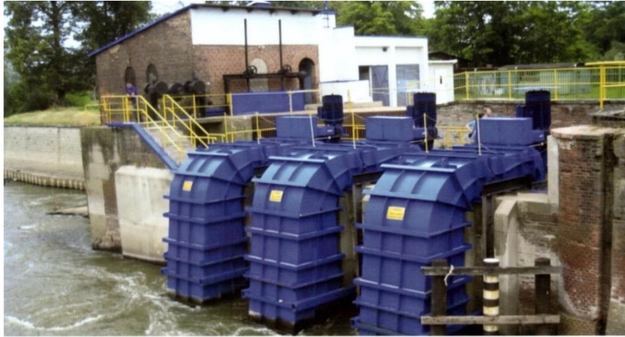
Рис. 1.5. Гідроелектростанція Olawa II (3 x TM10 Modular Micro H = 4,0 \text{ m} ; Q = 11,7 \text{ m}^3 \cdot \text{s}^{-1} ; N = 300 \text{ kW} )[31].
