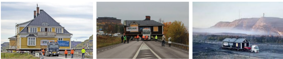
Рис. 5. Процес переміщення будівель
