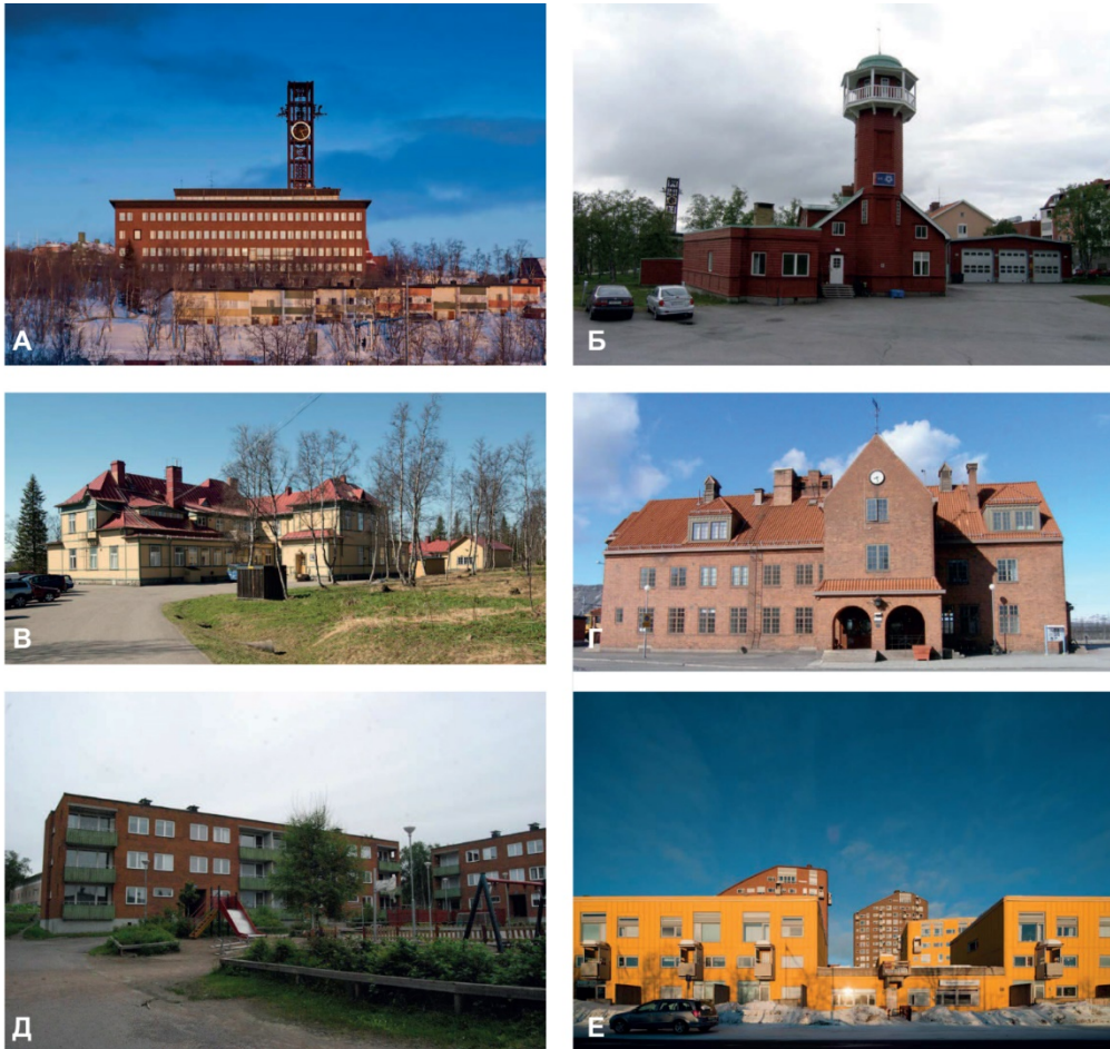
Рис. 4. Будівлі, що були знесені: А – ратуша, 1959–1962 рр., арх. А. фон Шмалензее; Б – пожежна станція, 1909 р., арх. Г. Вікман; В – готель компанії, 1909 р., арх. Г. Вікман; Г – залізнична станція, 1915 р., арх. арх. Ф. Зеттервалль; Д – житловий комплекс Ullspiran, 1960-ті рр.; Е – житловий квартал Ortdrivaren, 1959–1965 рр., арх. Р. Ерскін [10]
