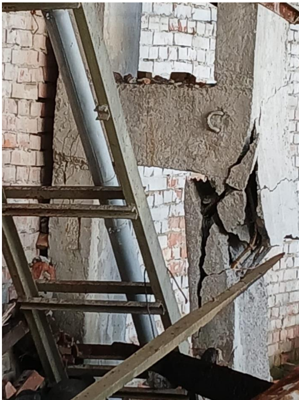
Рис. 1. Руйнування підкранової гілки: а) надкранової частини; б) двогілкової колони горизонтальною повітряною ударною хвилею
