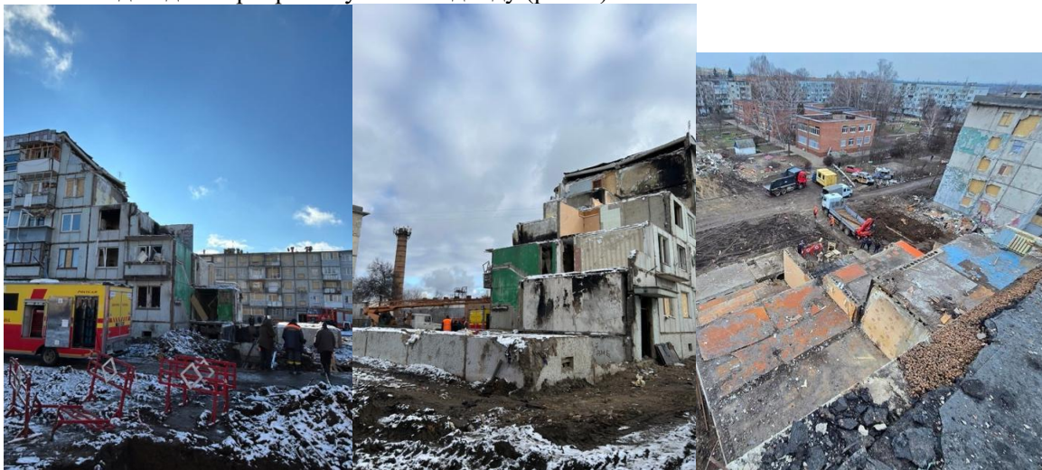
Рис. 1. Уражений ракетою будинок по вул. Баленка, 7
