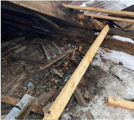
Рис.3. Гниття деревини
