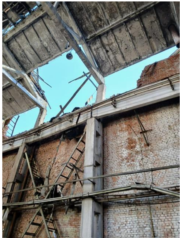
Рис. 1. Руйнування підкранової гілки: а) надкранової частини; б) двогілкової колони горизонтальною повітряною ударною хвилею
